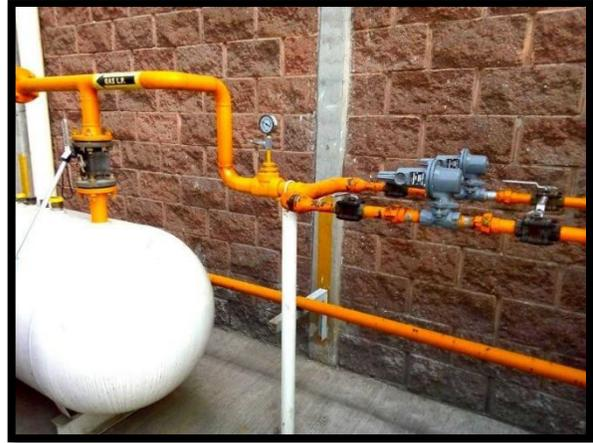
materiales resistentes a la acción del Gas L.P., contruidos de metal o cualquier otro material adecuado, con temperatura de fusión mínima de 988 K (714,85 C). Para el proyectó se propuso un tanque estacionario de 300ltrs con base a la siguiente tabla.
