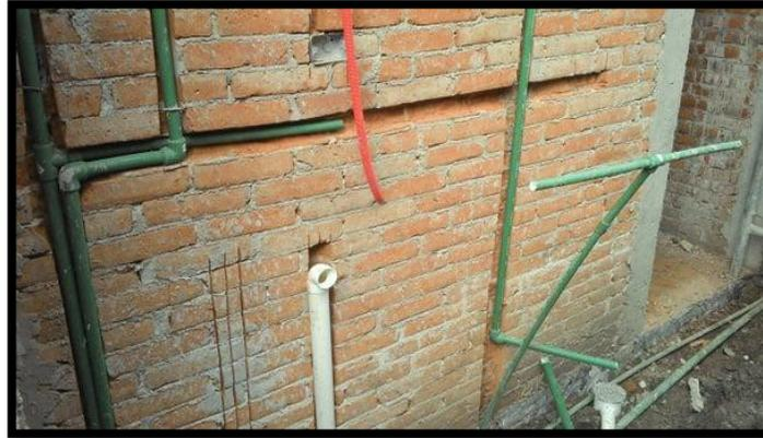
6. Toda conexión y/o tubería de por ser calentará con la herramienta por hasta conseguir derretir la materia para la conexión.
