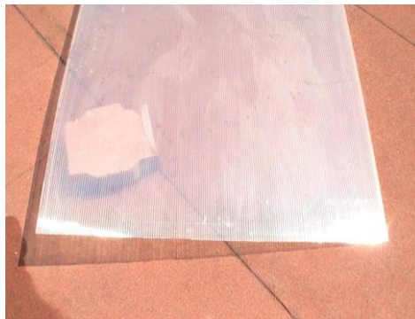
Figura 2.4.- Cubierta de policarbonato transparente utilizada como cubierta.
