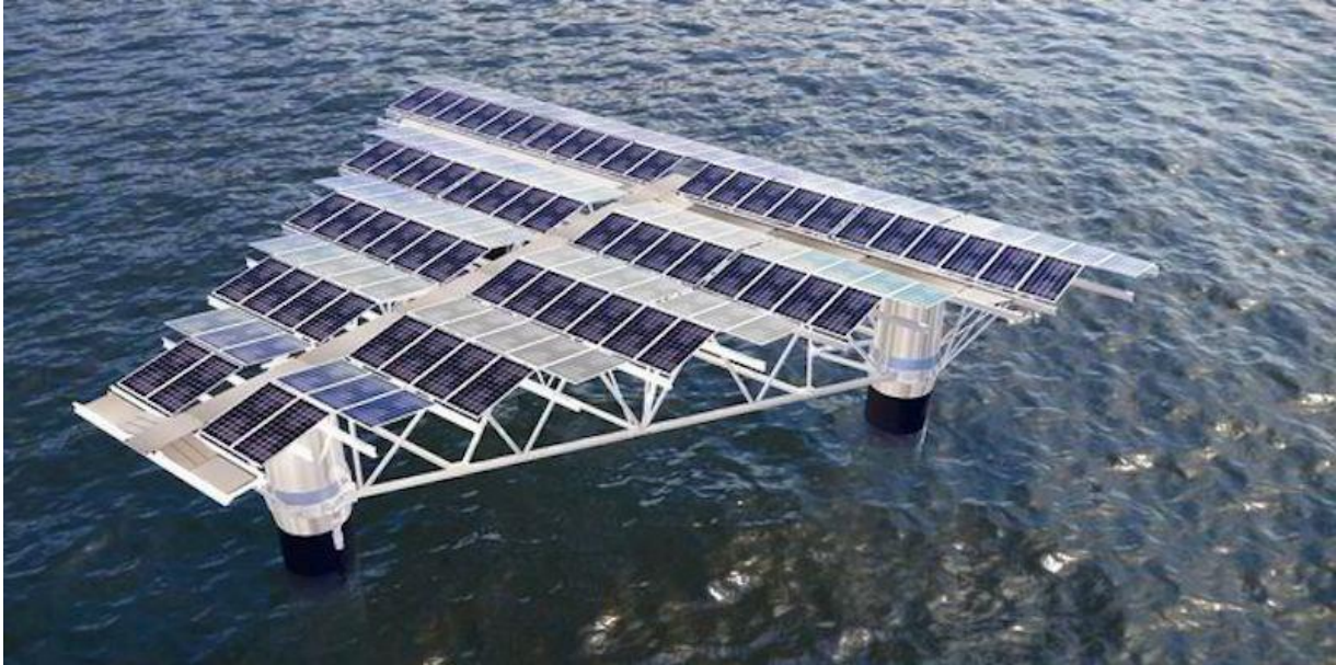
Figura 1.6 Parque solar flotante con sistema de almacenamiento en baterías ubicado en Tokio Japón.
