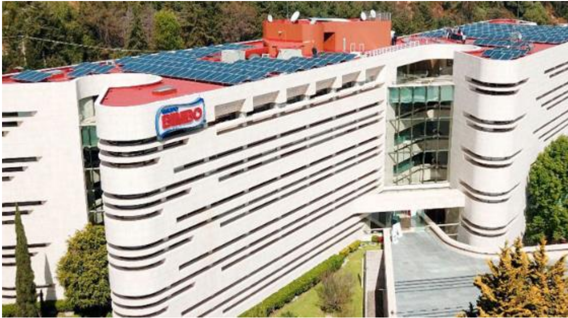
Figura 1.8 Instalación de paneles solares con almacenamiento en baterías en un edificio corporativo de Grupo Bimbo en México.
