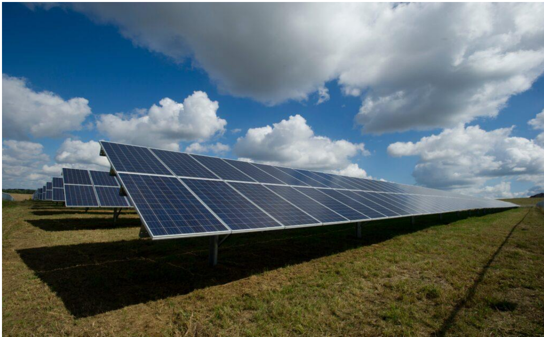
Figura 1.7 Instalación fotovoltaica con baterías ubicada en Rio de Janeiro Brasil.
