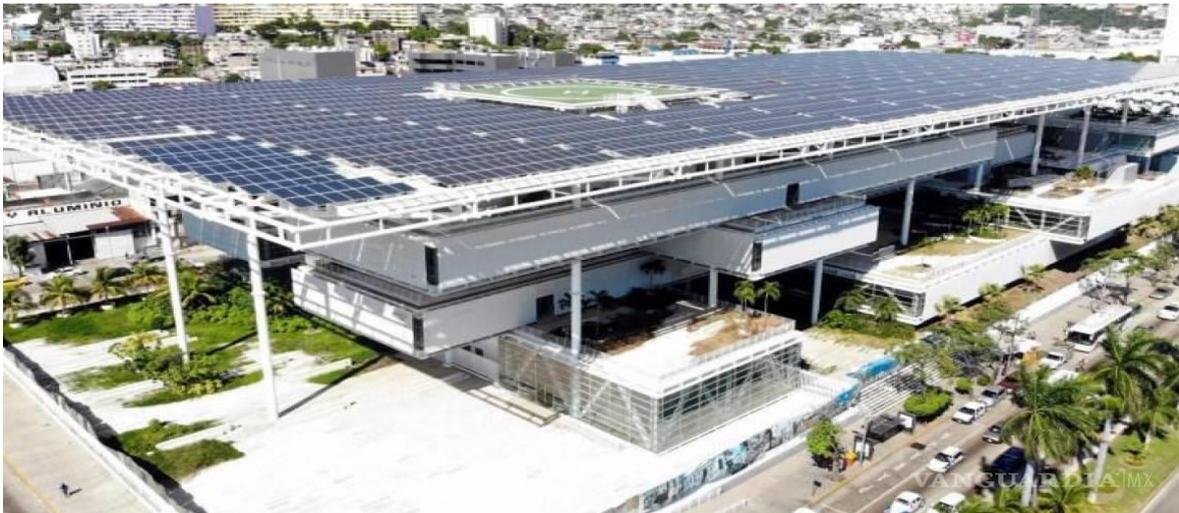
Figura 1.32 Paneles fotovoltaicos instalados en el Edificio Inteligente del Puerto de Acapulco.
