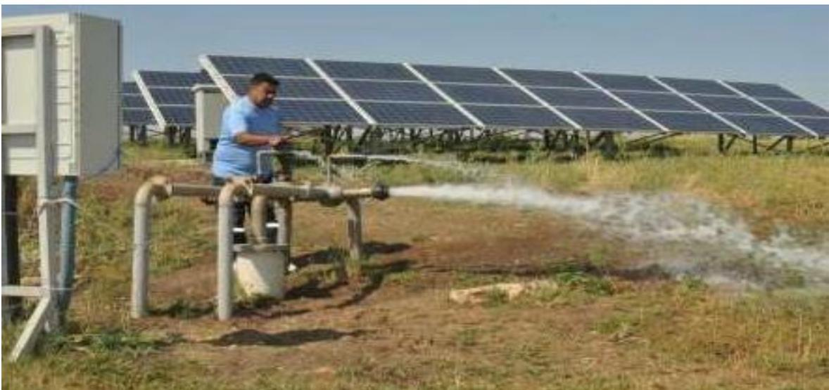
Figura 3.3 Bombeo solar (subclasificación del sistema autónomo).
