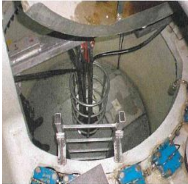
Figura 4.14 Detalle de la plataforma de la corona en una torre metálica
