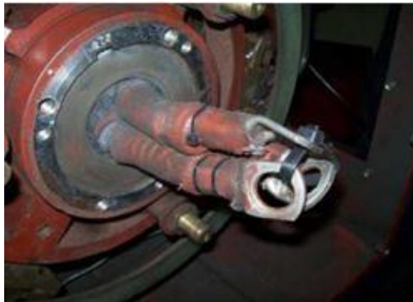
Figura 3.23 unir los tres cables con bridas
