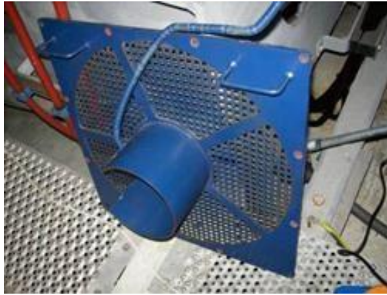
Figura 3.19 quitar con la carraca de ¼ los tornillos de la tapa trasera y apartar la tapa
