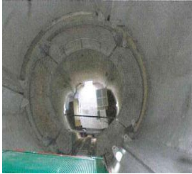
Figura 4.13 Detalles de una de las pasarelas intermedias de una torre de hormigón
