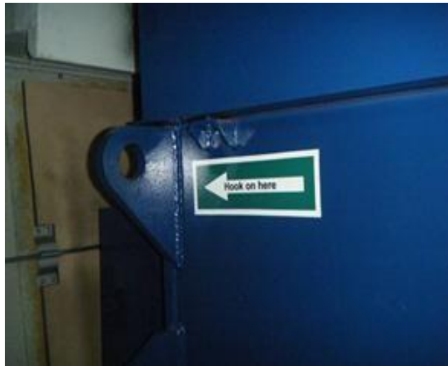
Figura 4.53 Asegurar el descensor a la orejeta del generador.
