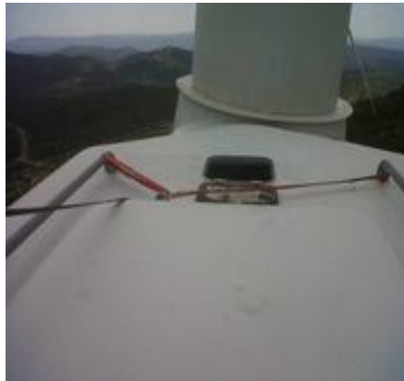
Figura 4.46 Configuración del punto de anclaje para el retráctil. Notar que las cintas están conectadas a los ojales de las barras para que limiten su deslizamiento
