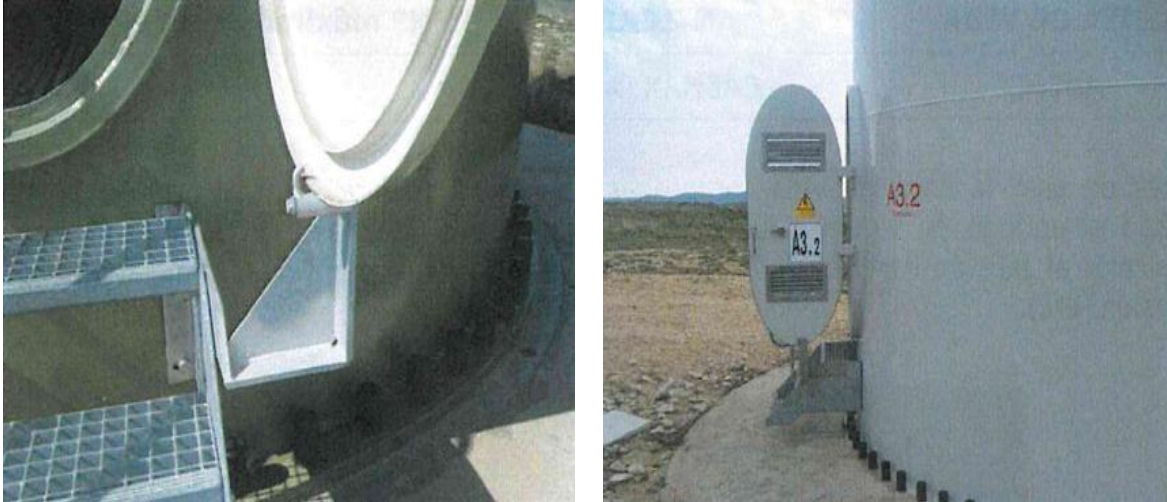
Figura 4.2 Sistema de retención de la puerta en aegs, AW1500 con torre metálica
