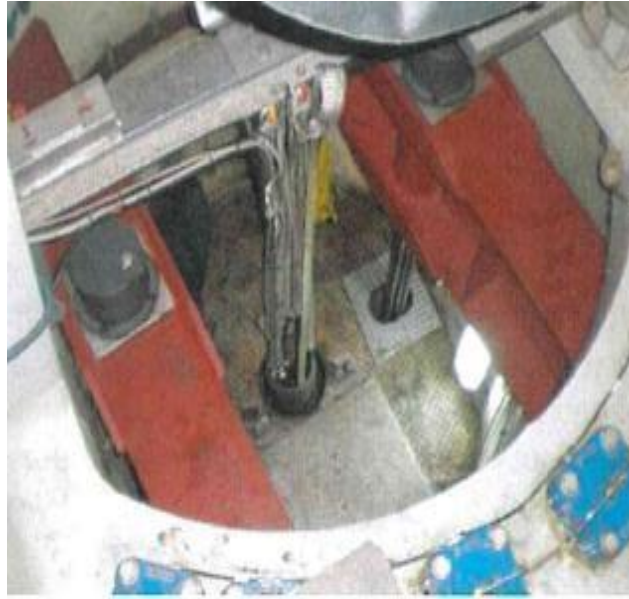
Figura 4.15 Detalle de la plataforma de la corona en una torre de hormigón
