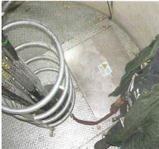
Figura 4.19 Al subir solo se podrá soltar el cabo de anclaje una vez cerrada la trampilla de la plataforma.
