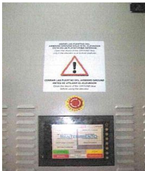
Figura 4.1 Pantalla en el armario ground
