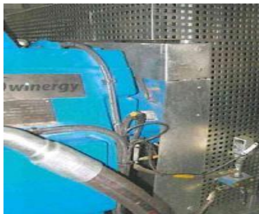
Figura 4.28 Protección metálica retrofitada para controlar la accesibilidad del disco
