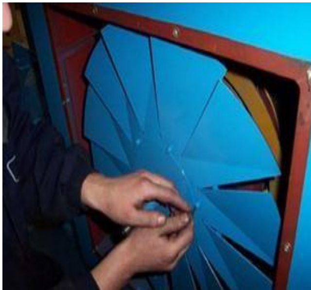
Figura 3.2 Soltar los tornillos hexagonales de unión del ventilador
