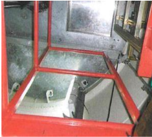
Figura 4.16 Elevador guían en el final superior del recorrido. Los elevadores de la marca Onís disponen de una barandilla similar
