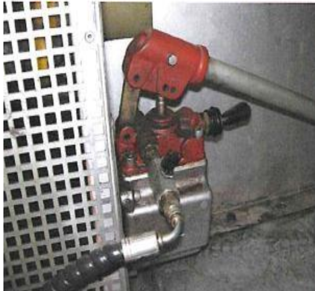
Figura 4.34 Bomba hidráulica de bloqueo
