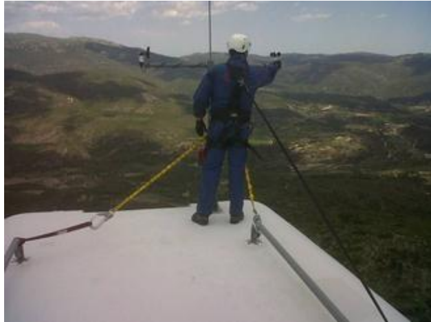
Figura 4.49 Detalle del acceso a la veleta y al anemómetro. Advertir que no se alcanza el anemómetro con el cabo izquierdo conectado si no se utiliza un anillo de cinta como punto de anclaje extra.
