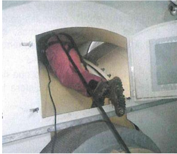
Figura 4.41 Tecnico accediendo al buje asegurado con el dispositivo retratil
