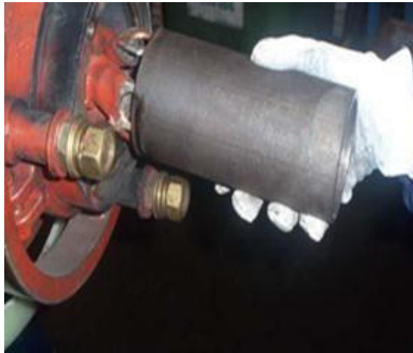
Figura 3.9 Introducir un tubo para proteger los cables.
