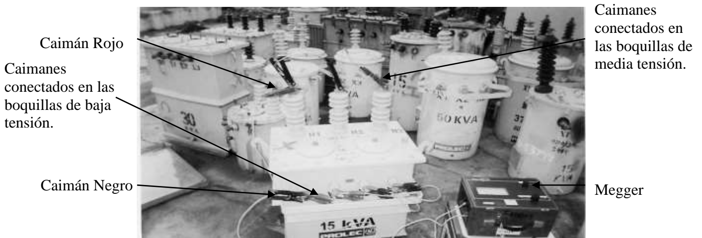
Figura 3.23 Prueba de un transformador de tres boquillas de alta con baja tensión
