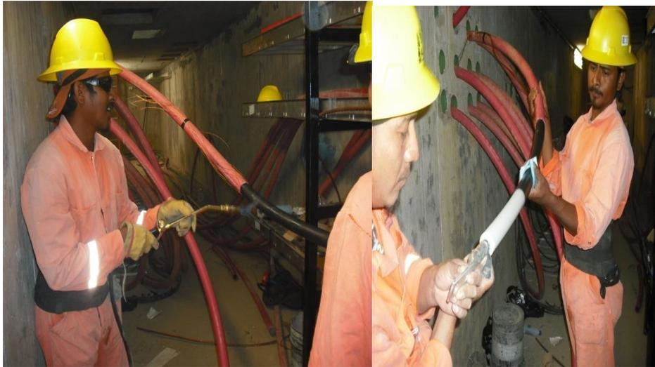
**Fig.17 elaboración de terminales termocontráctil.**
