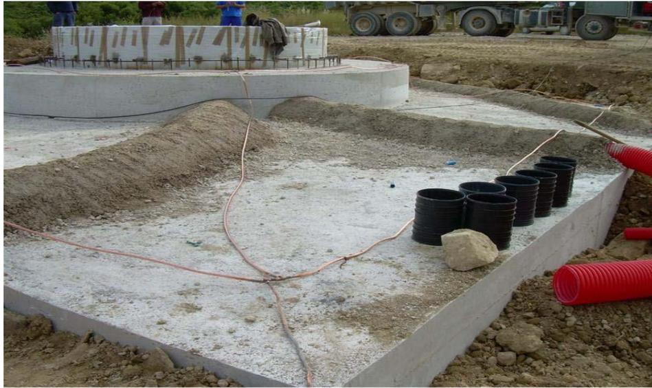
**Fig.25 anillos de sistema a tierra**
