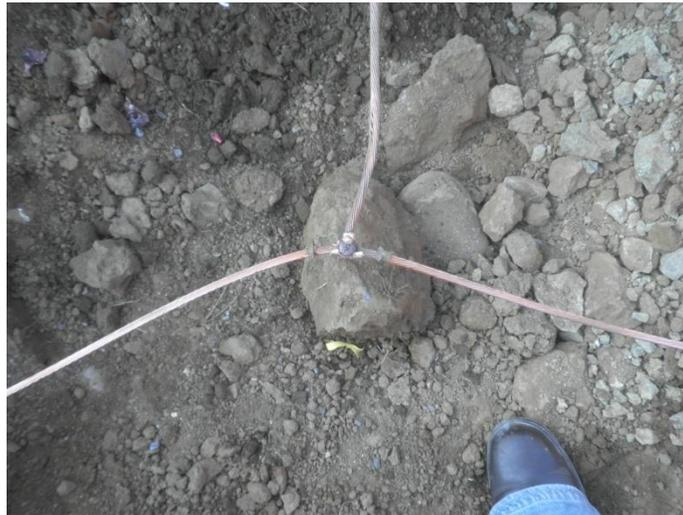
**Fig.30 Enlace mediante soldadura.**
