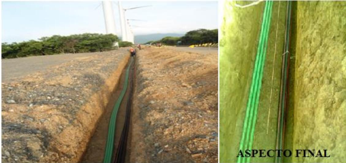
**Fig.8 Tendido del tritubo.**
