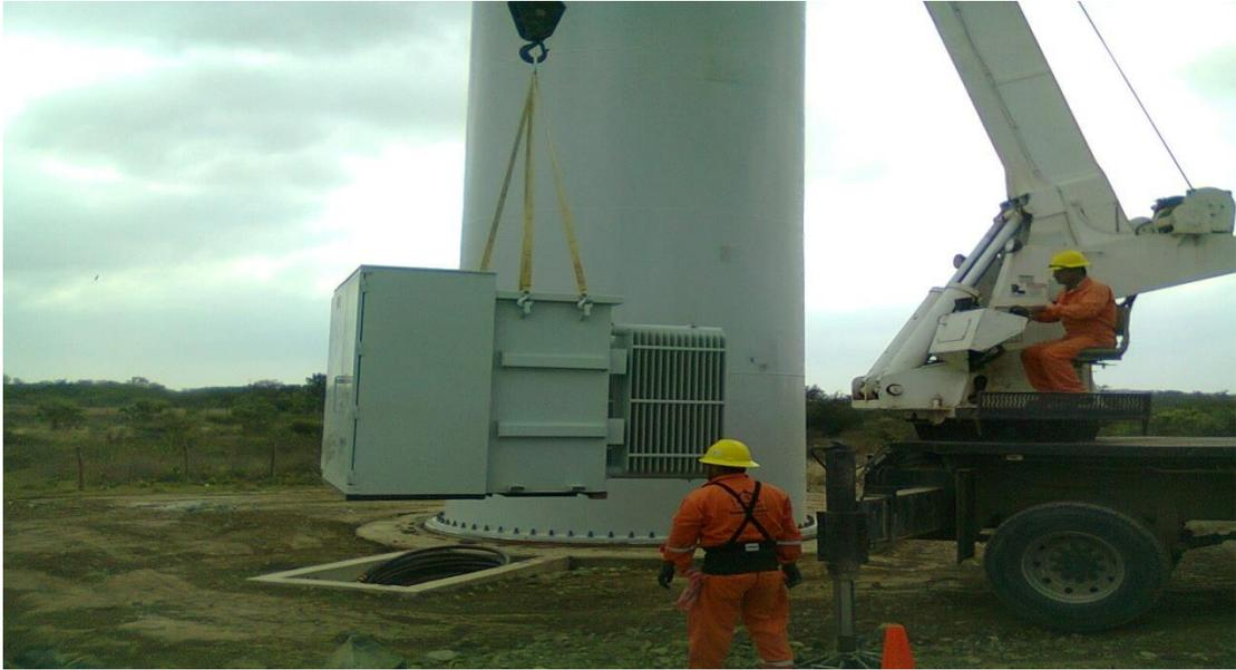
**Fig. 16 Montaje de transformador.**
