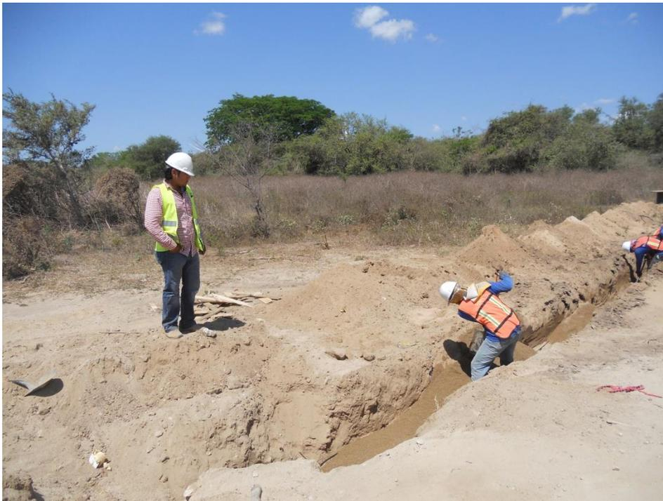
**Fig.11 Tapado con primera cama de arena para el sistema de tierra.**
