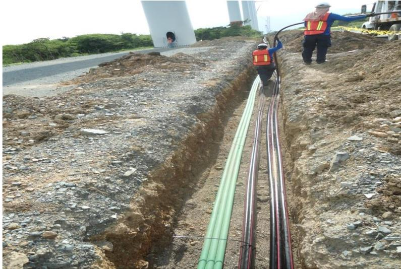
**Fig.26 Canalización de Aerogenerador a aerogenerador y con una evacuación de un circuito.**
