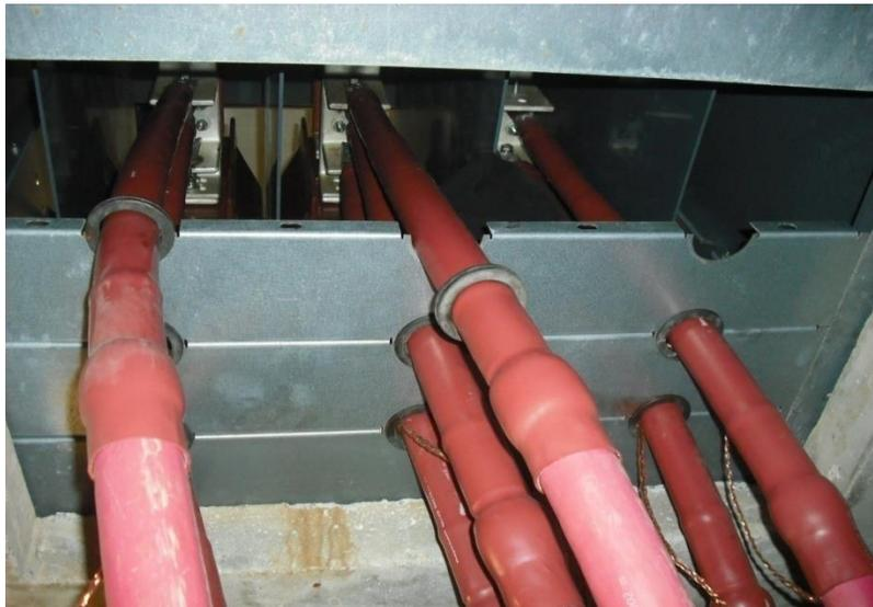
**Fig.19 terminales en celdas de subestación.**
