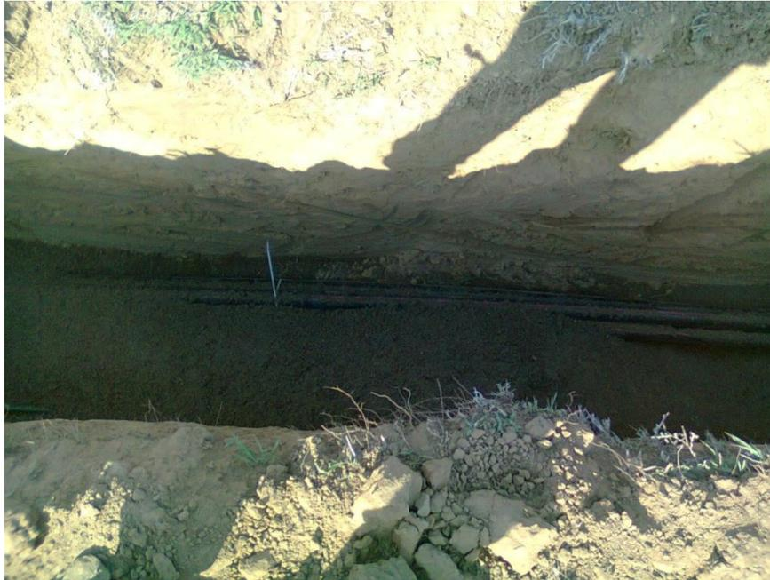
**Fig.12 Tapado con la segunda cama de arena sobre conductores.**
