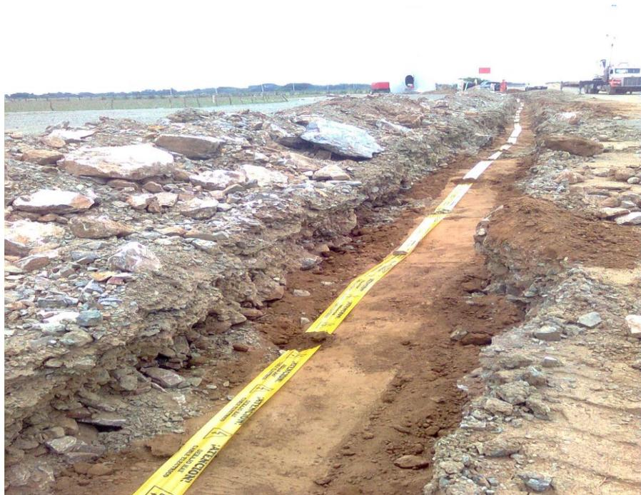
**Fig.14 Colocación de cinta de señalización sobre el material seleccionado.**
