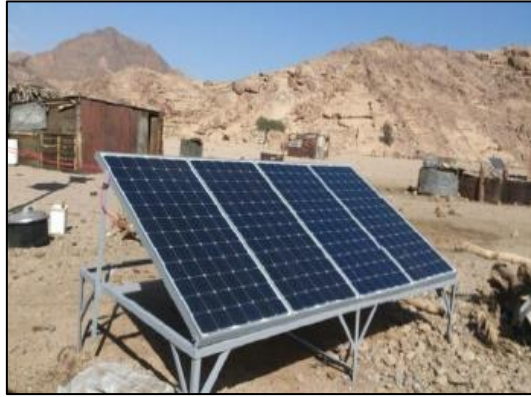
Figura 3.4. Instalación de un sistema fotovoltaico para brindar electricidad a una vivienda rural en Shalateen, Egipto. Fuente: (El-Shenawy, Hegazy, & Abdellatef, 2017).
