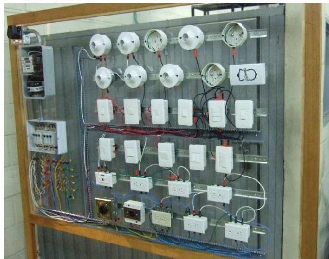
Figura 2.12 Fase final simulador de instalaciones domiciliarias
