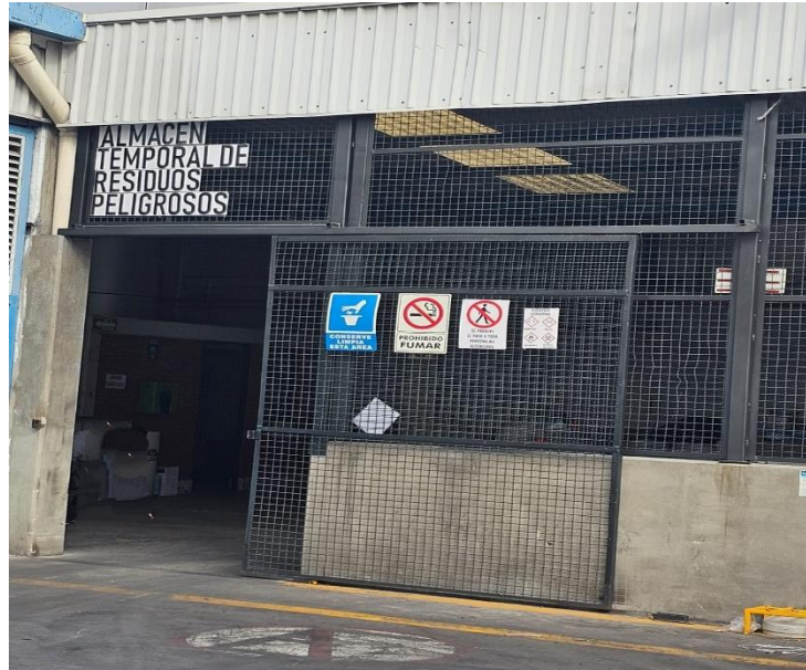
Figura 6. Almacén Temporal de Residuos Peligrosos Fuente: Obtenida de “La empresa”
