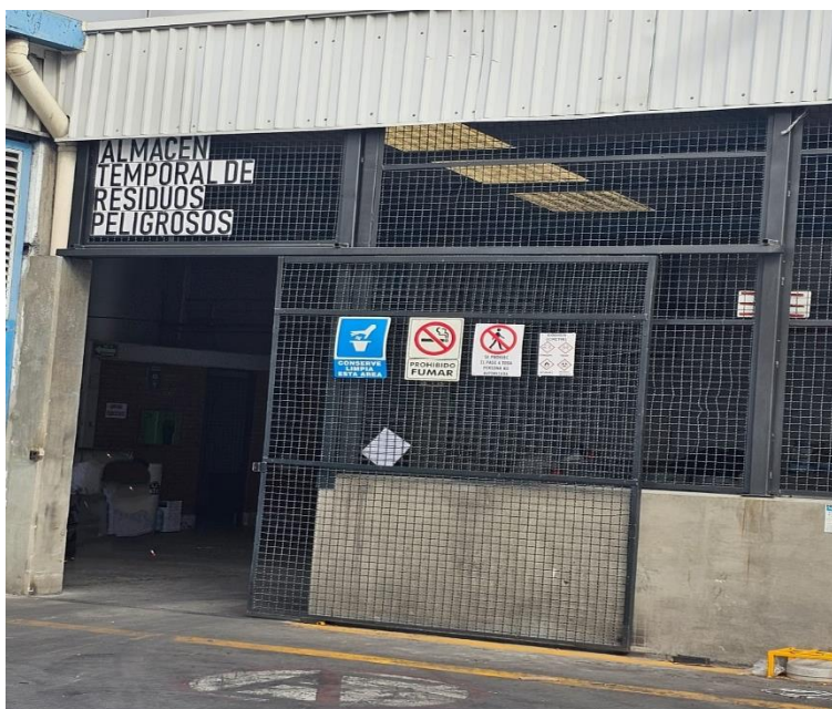
Figura 11.- Almacén Temporal de Residuos Peligrosos
