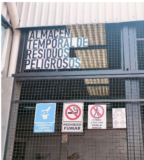
Figura 17.- Señalización del Almacén de Residuos Peligrosos.
