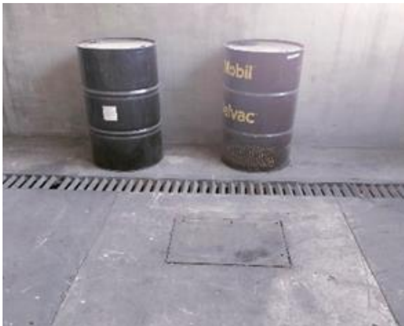
Figura 14.- Trinchera para detener posibles derrames.
