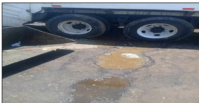
Figura 12. Segregación de lixiviados
