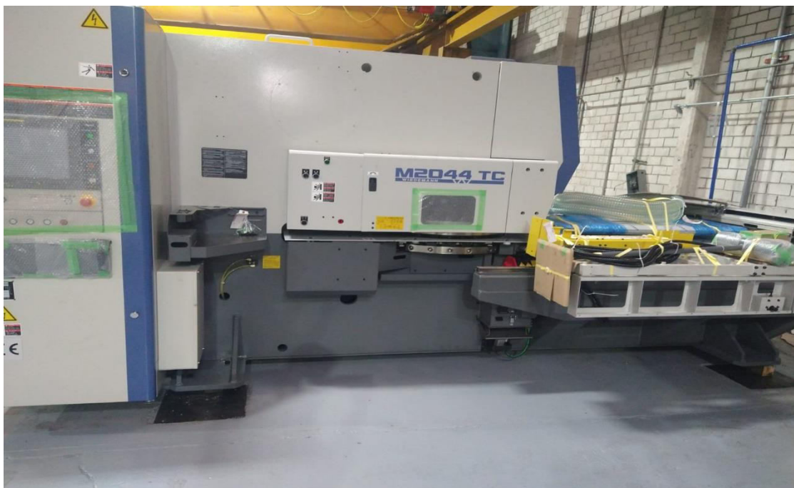
Ilustración 34. Maquinas Muratec en proceso de instalación.
