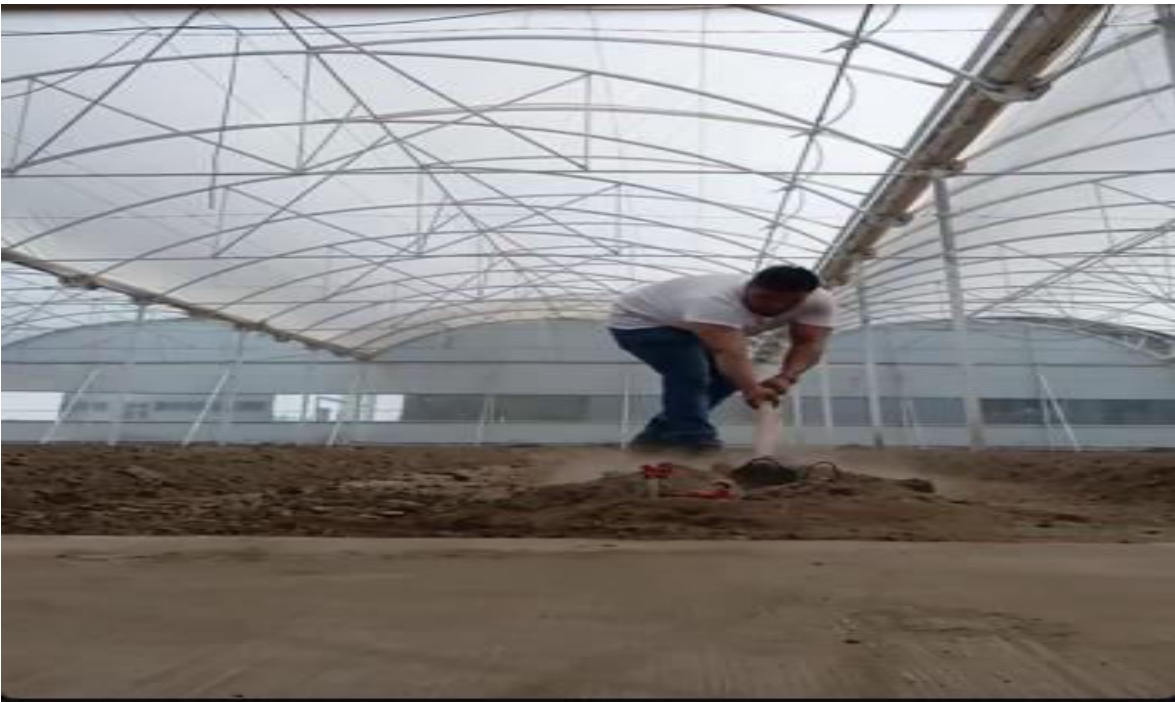
Figura 3. Preparación del terreno.
