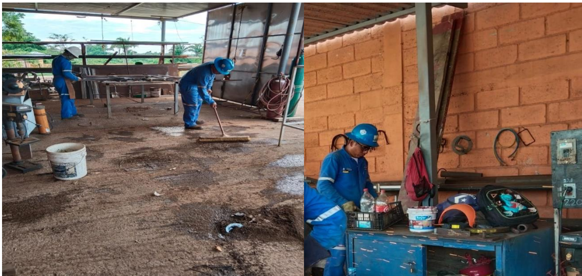
Figura 22 Etapa de Limpieza
