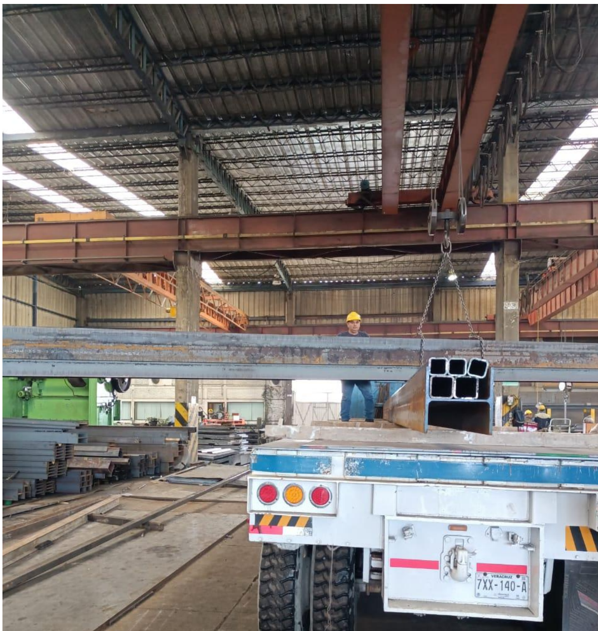
FIGURA 30 Descarga de vigas
