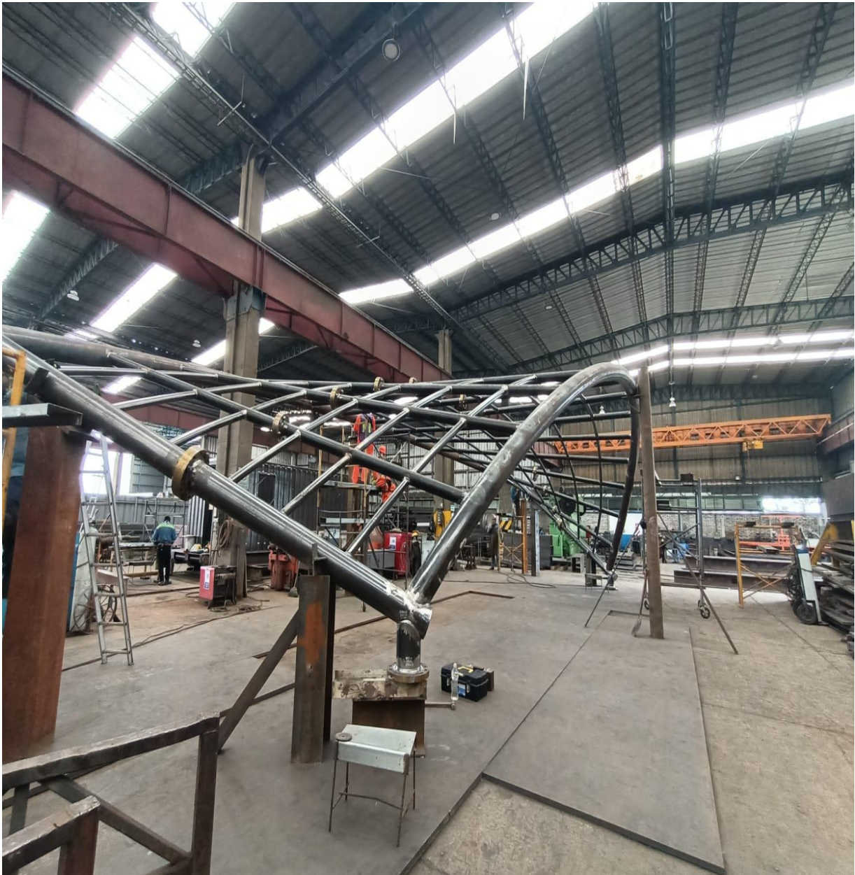
FIGURA 36 Fabricación de estructura grande
