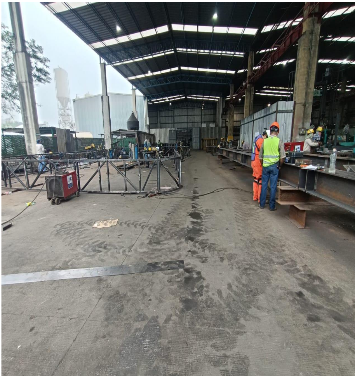
FIGURA 37 Fabricación de cubierta
