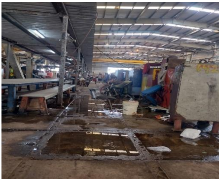
Ilustración 19 Espacio desordenado y con basura
