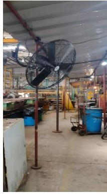
Ilustración 21 Instalación de Ventiladores
