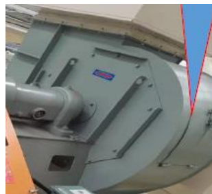
Figura 18. Ventilador de circulación de aire.
