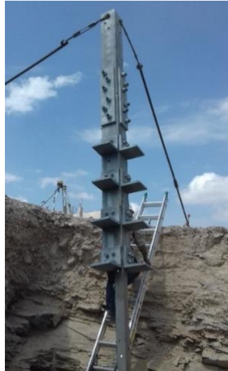
Figura 37.- Stub en terreno estable.
