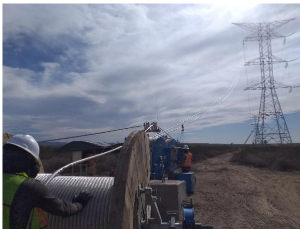
Figura 82.- Colocación del conductor en la máquina y vista grafica del carrete.
