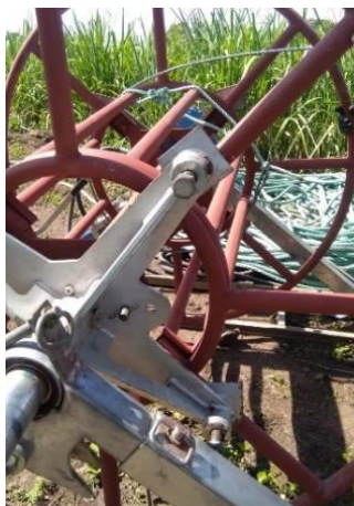
Figura 79.- Recuperación de cable guía. Obtenido de: García Sedas A. J., (2021). Reinstalación de cable de guarda en línea de transmisión de 400kV de Pachamama II.
