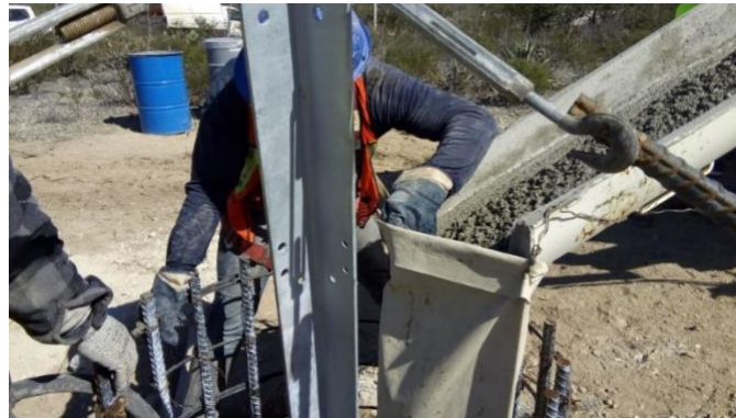
Figura 39.- Colocación de la media.
