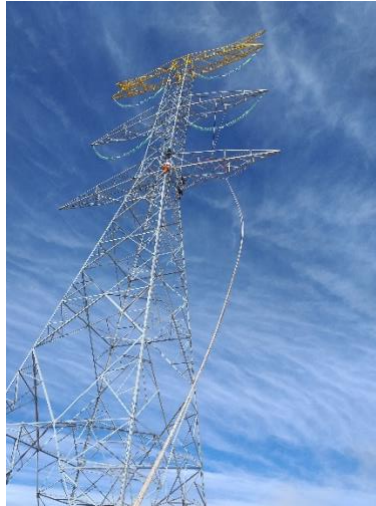
Figura 65.- Izaje de Aisladores.
