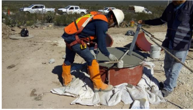
Figura 42.- Reparación de defectos en superficie.
