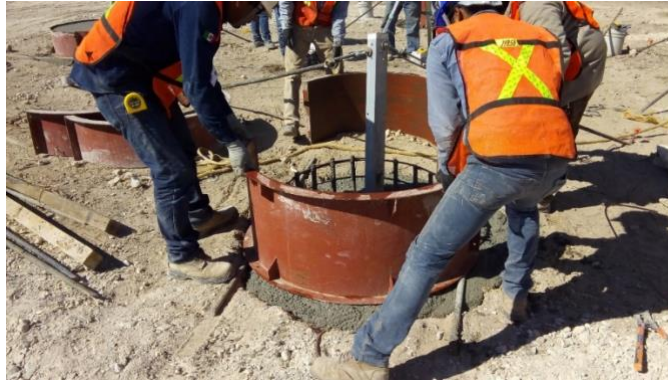
Figura 40.- Armado de un molde.
