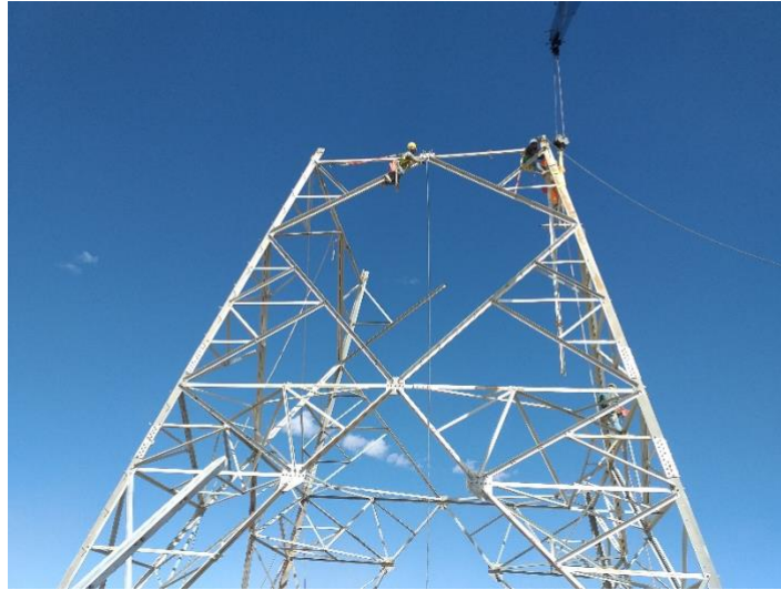
Figura 51.- Montaje del cuerpo piramidal.
