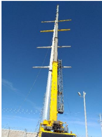
Figura 63.- Izaje de parte del troncocónico.
