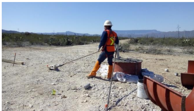
Figura 41.- Vaciado de hormigón terminado.
