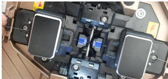
Figura 86.- Ejemplo de Fusión de fibra óptica. Obtenido de: García Sedas A. J., (2021). Reinstalación de cable de guarda en línea de transmisión de 400kV de Pachamama II.
