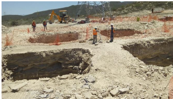
Figura 31.- Excavaciones delimitadas.
