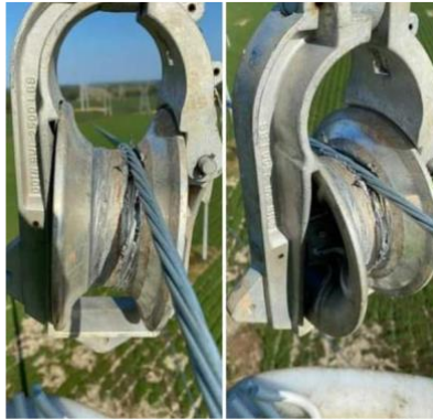
Figura 74.- Ejemplo de daños en poleas. Obtenido de: García Sedas A. J., (2021). Reinstalación de cable de guarda en línea de transmisión de 400kV de Pachamama II.
