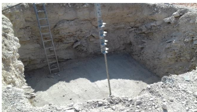
Figura 35.- Primeras alineaciones del stub.
