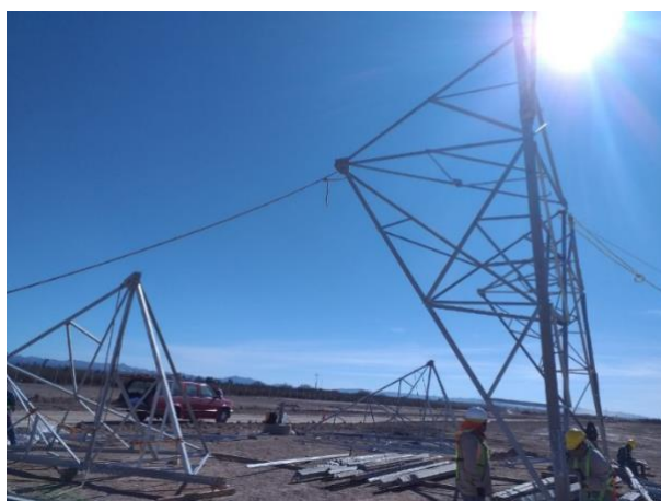
Figura 47.- Armado y ensamblado del botón panel.
