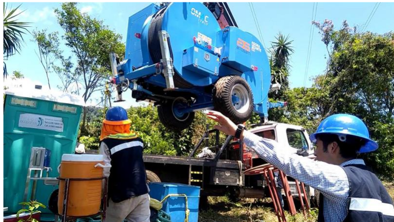
Figura 75.- Izaje de la máquina. Obtenido de: García Sedas A. J., (2021). Reinstalación de cable de guarda en línea de transmisión de 400kV de Pachamama II.
