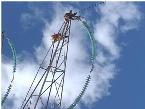
Figura 67.- Fijación de cadena de aisladores.
