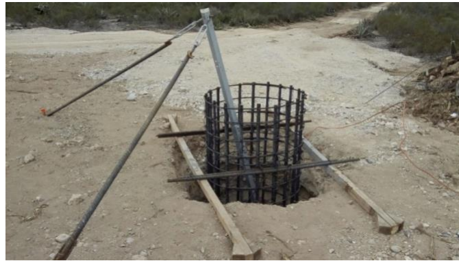
Figura 38.- Soportes del stub.
