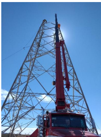
Figura 52.- Izaje del vestido de la armadura.
