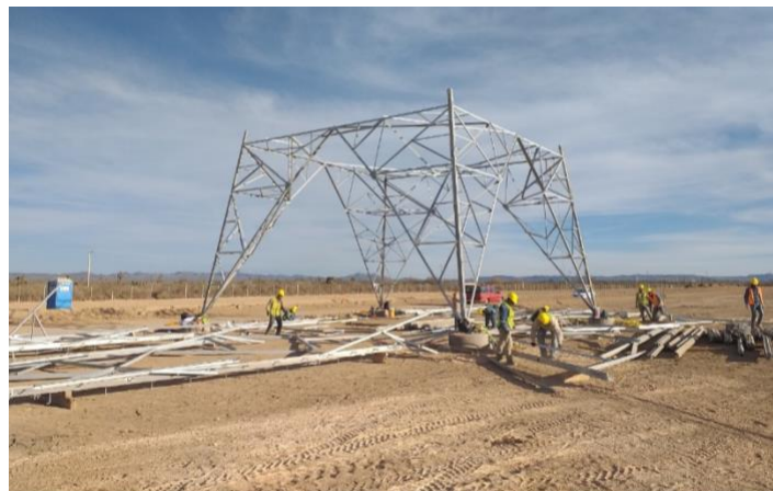
Figura 49.- Boton panel armado y montado
