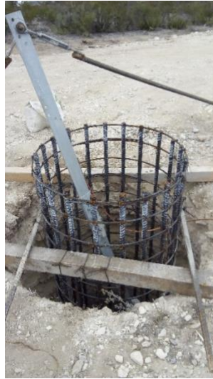
Figura 36.- Colocación de stub.
