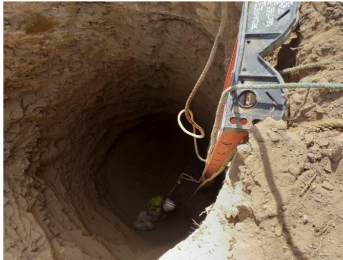
Anexo 2.- Daños a una torre
