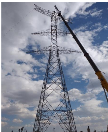
Figura 58.- Ultimo Izaje en torre.
