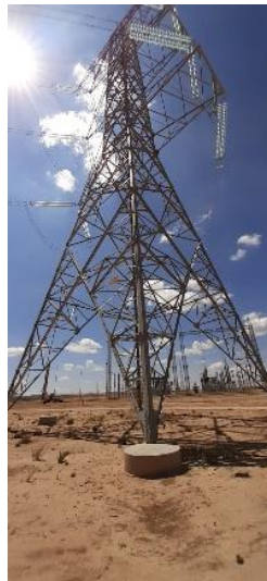
Figura 11.- Torre de remate.
