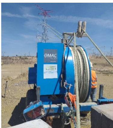
Figura 81.- Cable guía colocado en la máquina.
