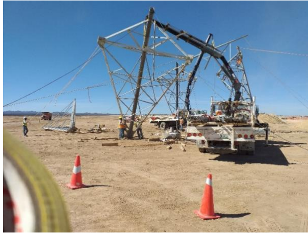
Figura 48.- Colocación de piezas con apoyo de grúa.
