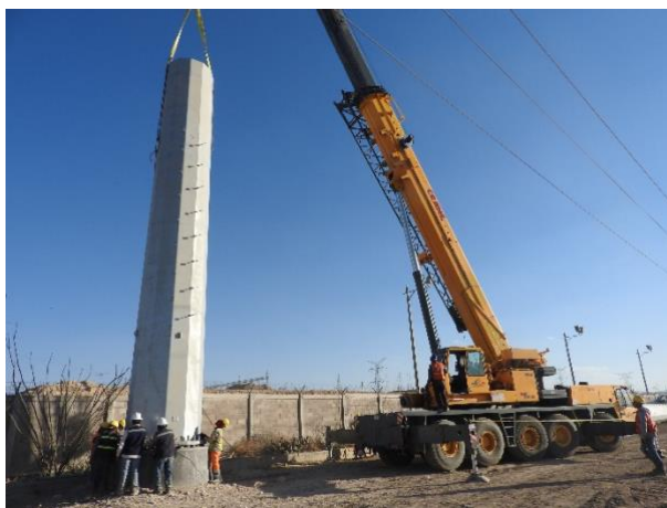
Figura 62.- Primera parte del troncocónico.
