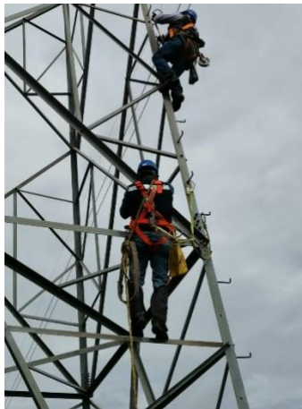
Figura 73.- Linieros subiendo el material. Obtenido de: García Sedas A. J., (2021). Reinstalación de cable de guarda en línea de transmisión de 400kV de Pachamama II.
