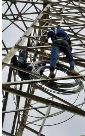
Figura 85.- Bajada del cable OPGW para su fusión. Obtenido de: García Sedas A. J., (2021). Reinstalación de cable de guarda en línea de transmisión de 400kV de Pachamama II.
