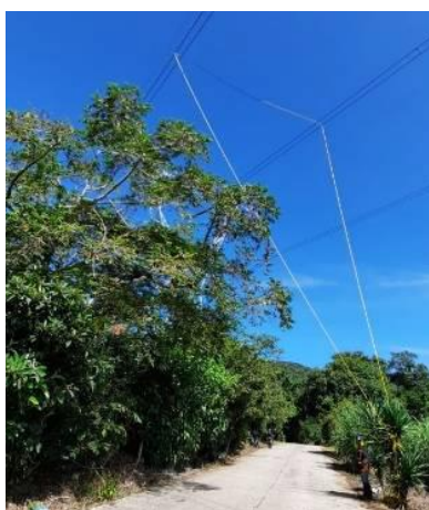
Figura 70.- Violín en cruce de carretera. Obtenido de: García Sedas A. J., (2021). Reinstalación de cable de guarda en línea de transmisión de 400kV de Pachamama II.
