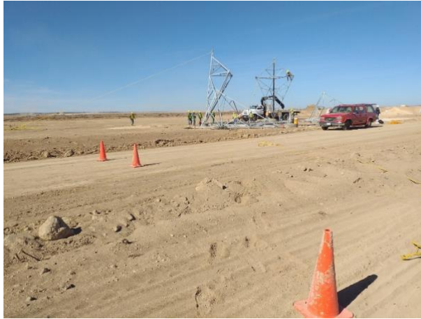
Anexo 3.- Patas de la torre.
