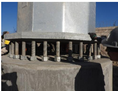
Figura 61.- Colocación en cimentación.
