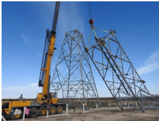
Figura 53.- Levantamiento del cuerpo recto.
