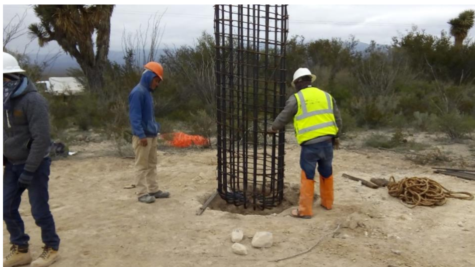
Figura 32.- Colocación de los churros.
