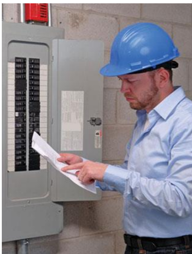
Imagen 2.- Inspección de una UVIE
