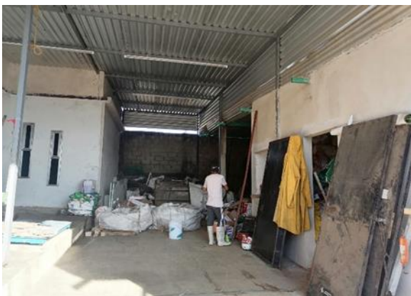
Imagen 10. la situación que se encontraba la empresa
