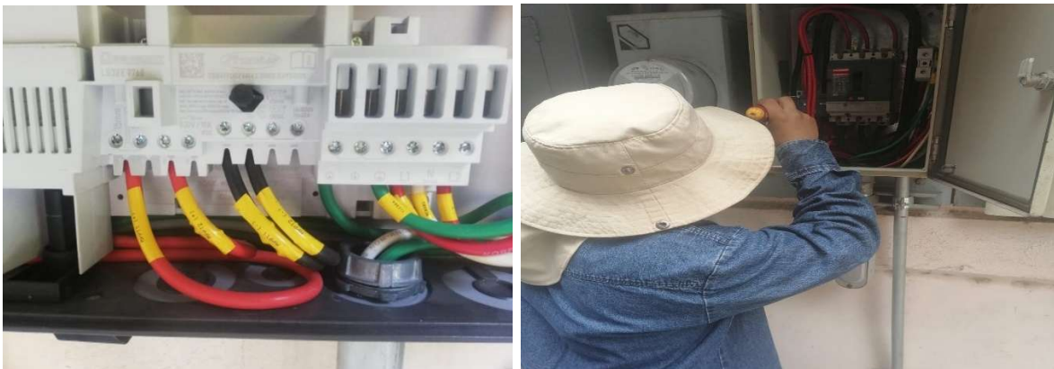
Imagen 19. Procesos para la instalación del inversor.
