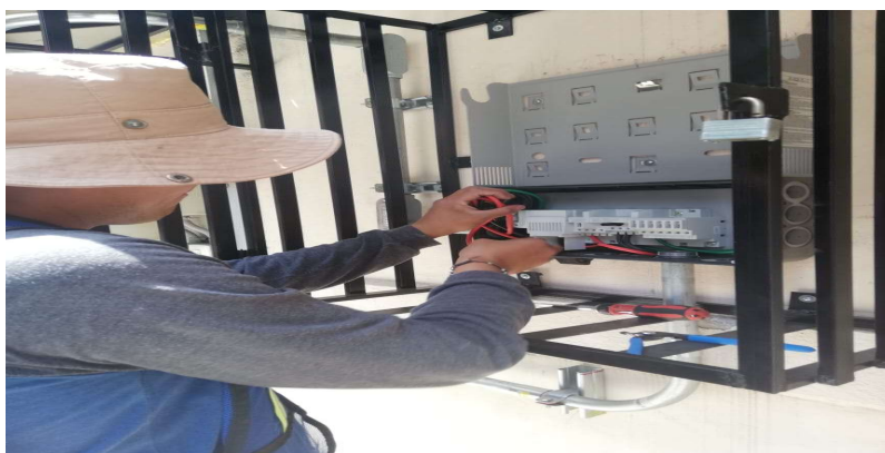
Imagen 18. Instalación del inversor de cadena.
