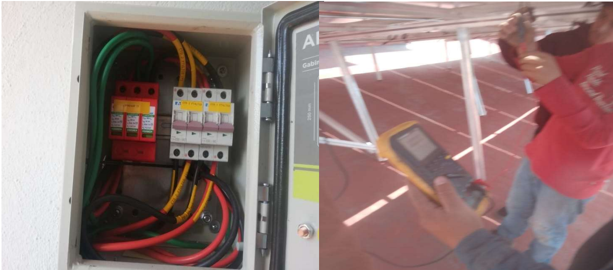
Imagen 16. Procesos de instalación de los módulos a los DCPS de corriente directa.
