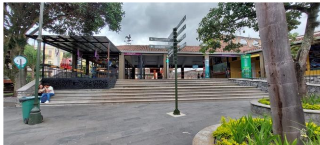
Ilustración 4.2 Instalaciones del Teleférico, Orizaba
