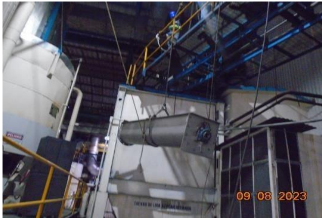
Imagen 4.14. Elevación de la primera sección de conductor.
