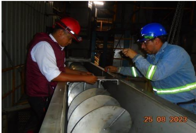
Imagen 4.18. Instalación de puentes intermedios con buje.
