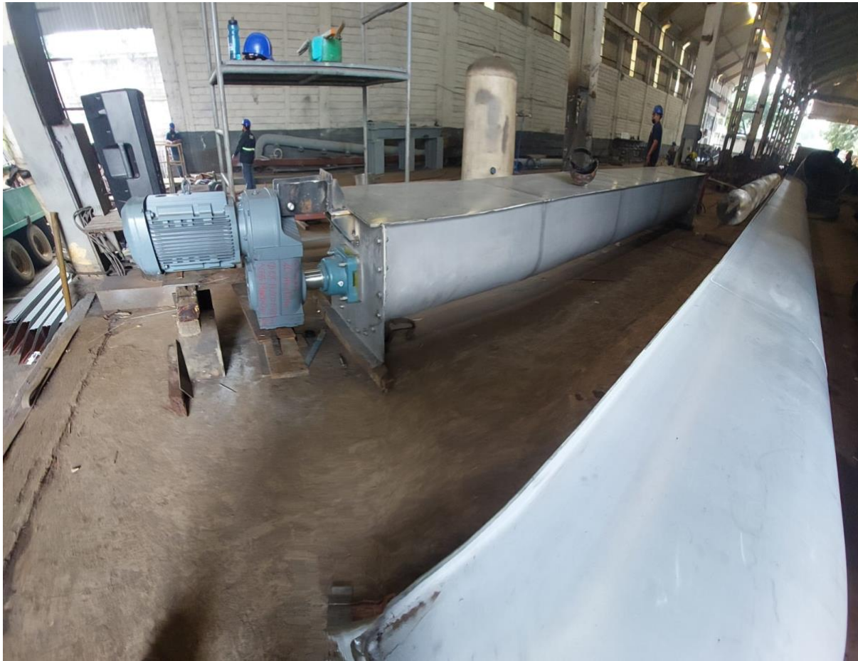
Imagen 3.25. Ensamblado final total de conductor helicoidal.
