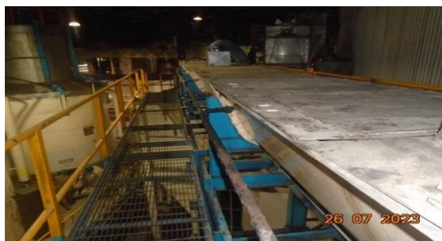
Imagen 4.2. Conductor helicoidal a cambiar.
