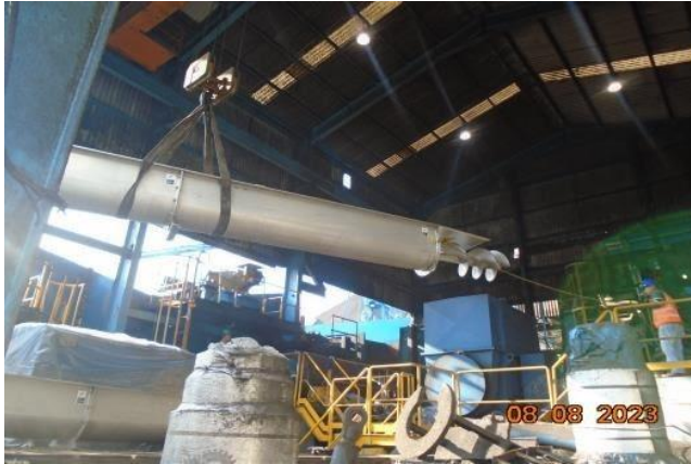
Imagen 4.12. Elevación en dos niveles.
