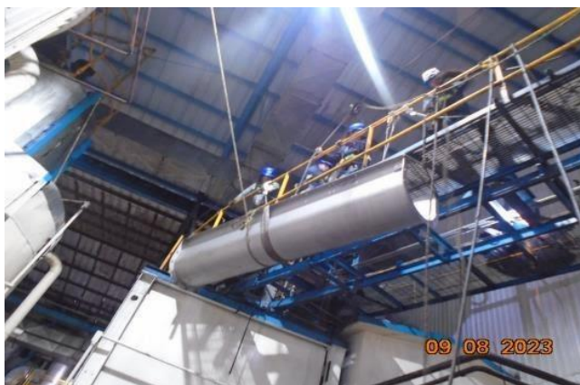
Imagen 4.15. Segunda sección de artesas del conductor.
