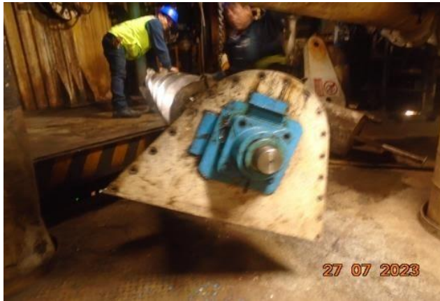
Imagen 4.5. Traslado de tornillo, por el personal.
