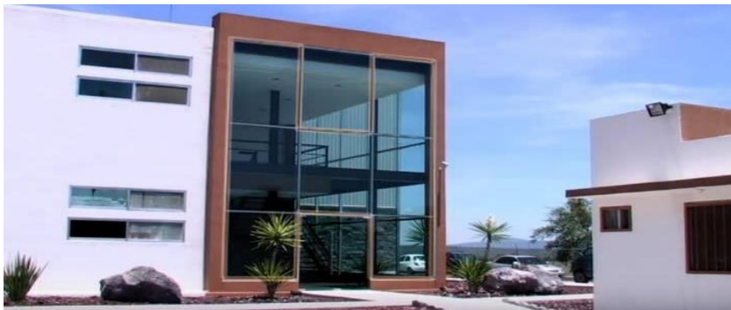
Ilustración 3. Fachada de la empresa Hiroma Plast S.A de C. V (C.V H. P., 2019)
