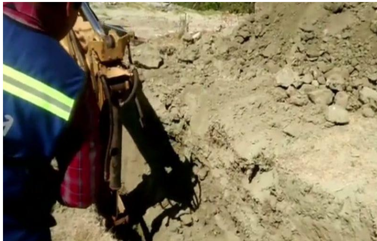
Foto 1. Excavación a cielo abierto
