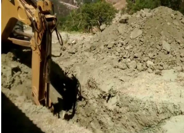
Foto 2. Excavación a cielo abierto
