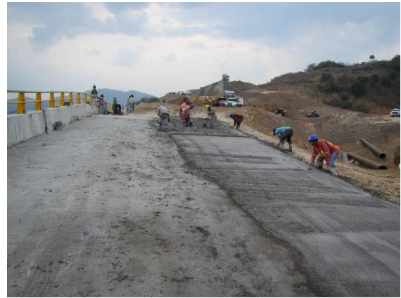
COLOCACIÓN DE CONCRETO FLUIDO CON ESPESOR DE 0.25 M.
