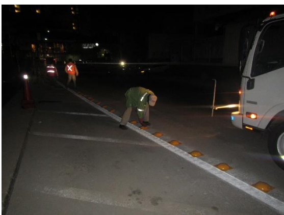
COLOCACIÓN DE SEÑALAMIENTO HORIZONTAL, BOYAS METÁLICAS, HACIA AV. PALMA DÁTIL.
