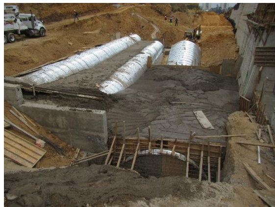
COLOCACIÓN DE CONCRETO FLUIDO SOBRE ARCOS METÁLICOS.
