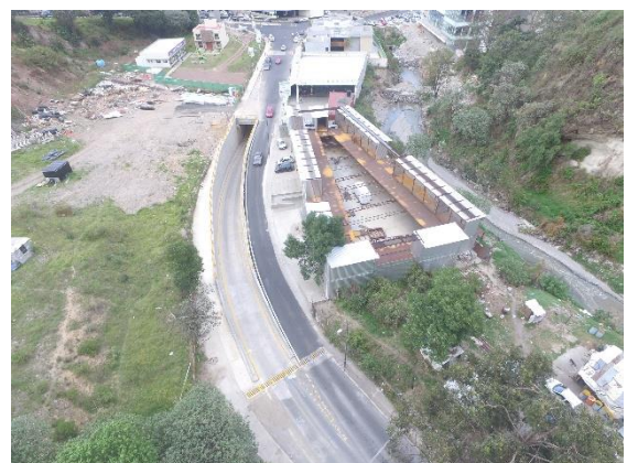
VISTA PANORÁMICA DE RAMPA DE SALIDA DEL DEPRIMIDO, HACIA AV. PALMA DÁTIL.
