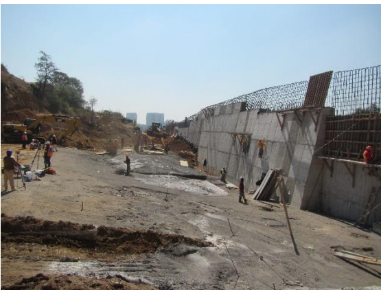
COLOCACIÓN DE ACERO PARA MURO DE CONTENCIÓN.
