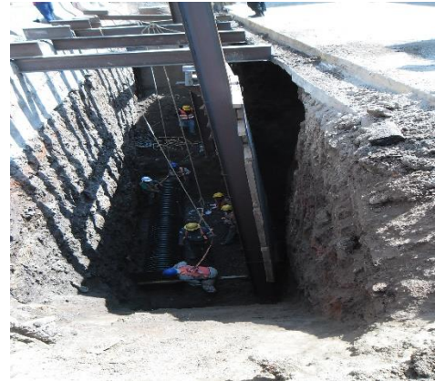
COLOCACIÓN DE TUBO CORRUGADO PARA DRENAJE PLUVIAL, DEL LADO DE AV. PALMA DÁTIL.
