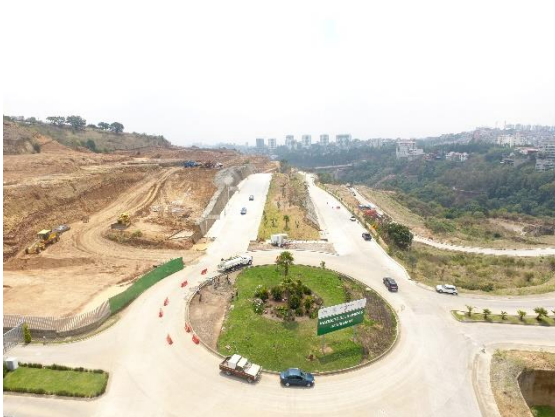
VISTA PANORÁMICA DE OBRA TERMINADA, KM. 0+600.
