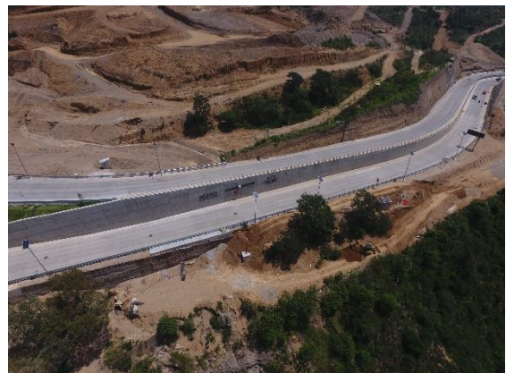
VISTA PANORÁMICA DE OBRA TERMINADA, CON SEÑALAMIENTO INSTITUCIONAL SCT, SOBRE MURO DE CONTENCIÓN.
