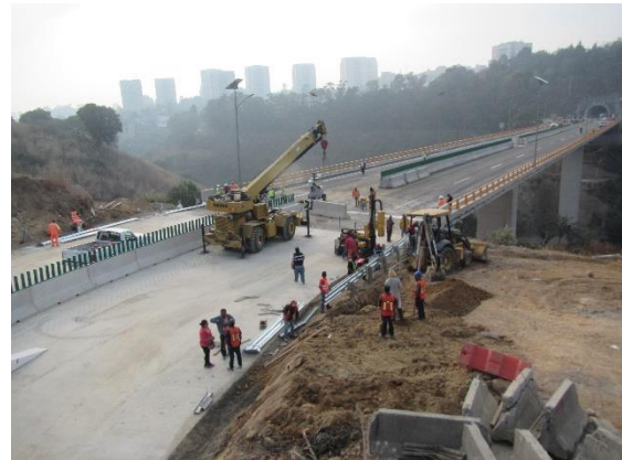
COLOCACIÓN DE DEFENSA METÁLICA DE 3 CRESTAS.
