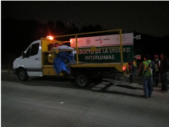
COLOCACIÓN DE SEÑALAMIENTO VERTICAL ELEVADO HACIA VIADUCTO CUERPO DERECHO.
