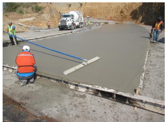
TENDIDO DE CONCRETO HIDRÁULICO MR 45, EN CUERPO DERECHO.
