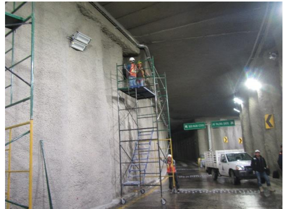
COLOCACIÓN DE LUMINARIAS EN DEPRIMIDOS.
