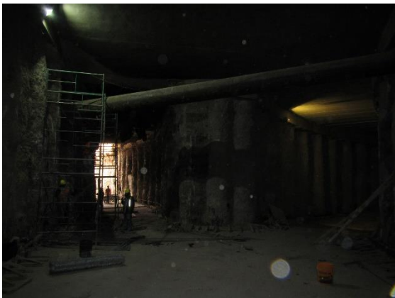
TRABAJOS DE COLOCACIÓN DE MALLA PARA CONCRETO LANZADO EN DEPRIMIDO.
