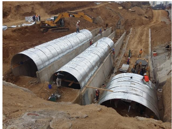
COLOCACIÓN DE ARCOS METÁLICOS SOBRE DUCTOS DE AGUA POTABLE.
