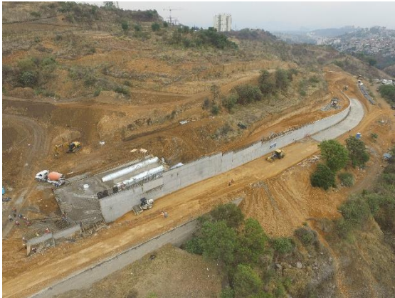
PANORÁMICA DE ARCOS METÁLICOS, MURO DE CONTENCIÓN Y TERRACERÍAS.
