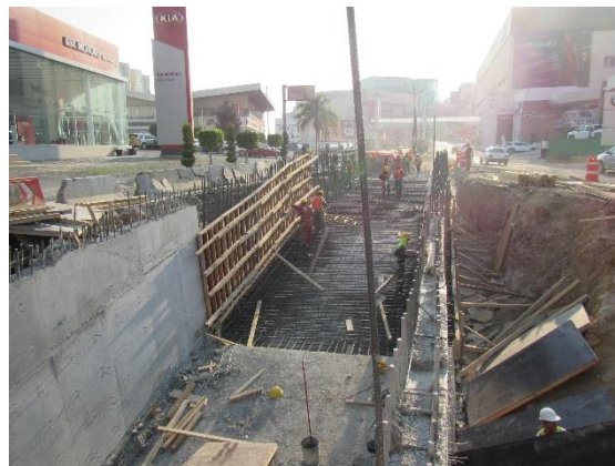
COLOCACIÓN DE ACERO Y CIMBRADO DE MUROS, HACIA BLVD. MAGNO CENTRO.
