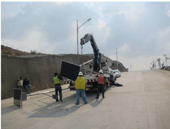
COLOCACIÓN DE ALUMBRADO PÚBLICO CON PANEL SOLAR, SOBRE CUERPO IZQUIERDO EN VIALIDAD.
