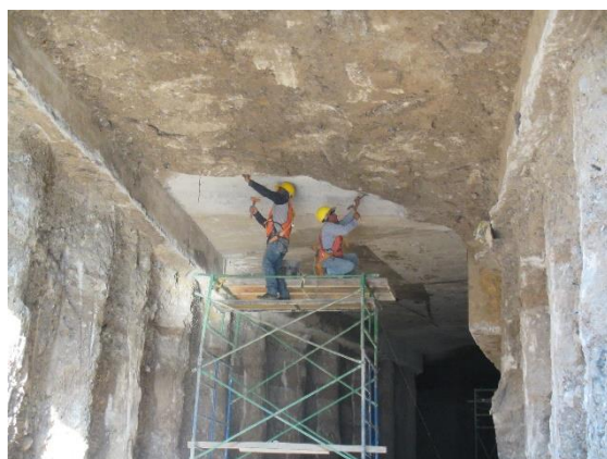
RETIRO DE PLANTILLA QUE CONTIENE LA LOSA DE LOS DEPRIMIDOS.
