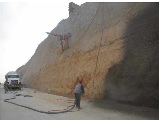
COLOCACIÓN DE CONCRETO LANZADO EN TALUD LADO DERECHO, KM. 0+020.
