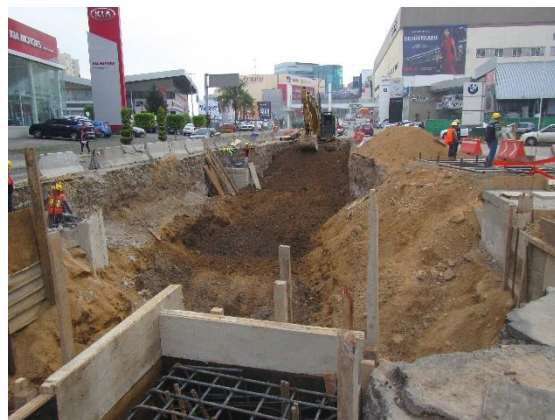
TRABAJOS DE EXCAVACIÓN Y NIVELACIÓN DE SALIDA DE DEPRIMIDO, HACIA BLVD. MAGNO CENTRO.
