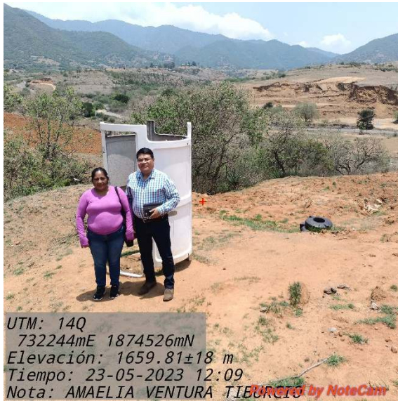
Fotografía 5 Caseta del sanitario y biodigestor.
