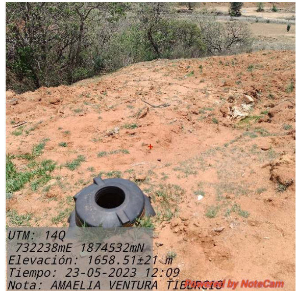
Fotografía 6 Biodigestor, foco de infección.
