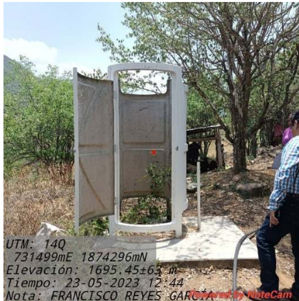
Imagen 4.2 Caseta de los sanitarios con biodigestor.
