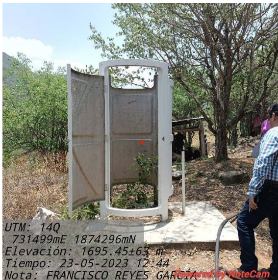
Fotografía 11 Caseta del sanitario
