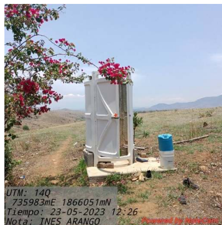
Imagen 4.5 Puerta del Sanitario con biodigestor, con pasador corredizo.
