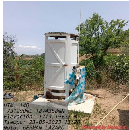
Imagen 4.6 Vanos inferior y superior del sanitario para iluminación y ventilación.
