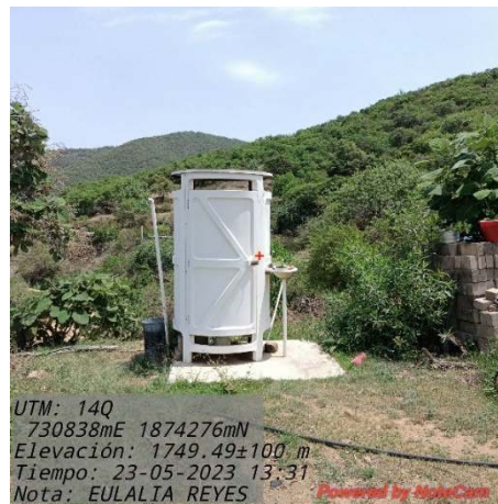
Imagen 4.7 Vanos en la caseta del sanitario para iluminación y ventilación
