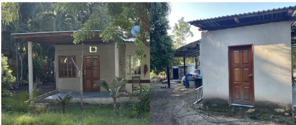
Imagen 22. Modificación realizada a una vivienda tipo P3 en Palmar
