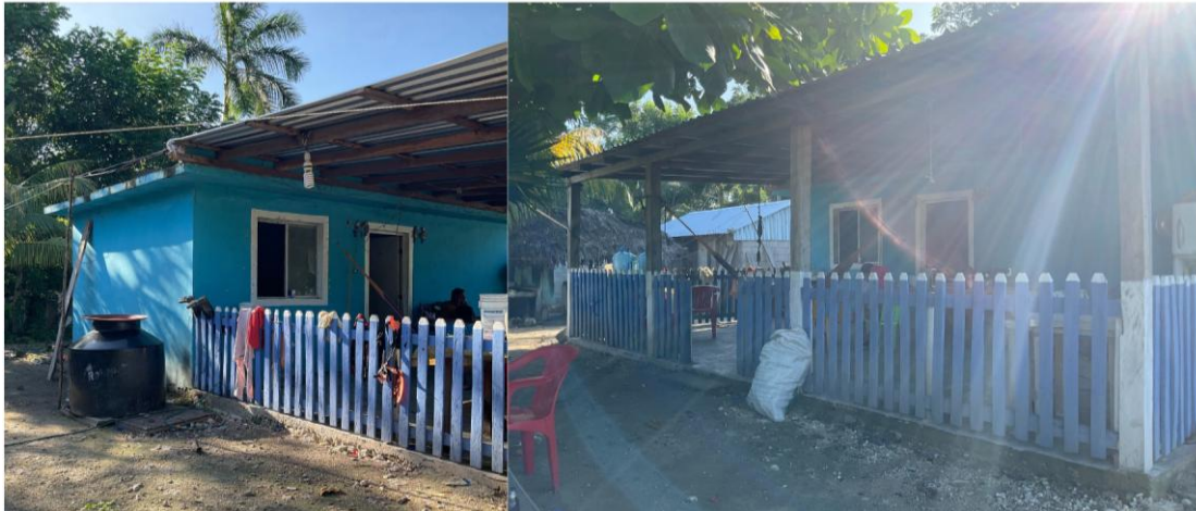
Imagen 12. Modificación realizada a una vivienda tipo P1 en Palmar
