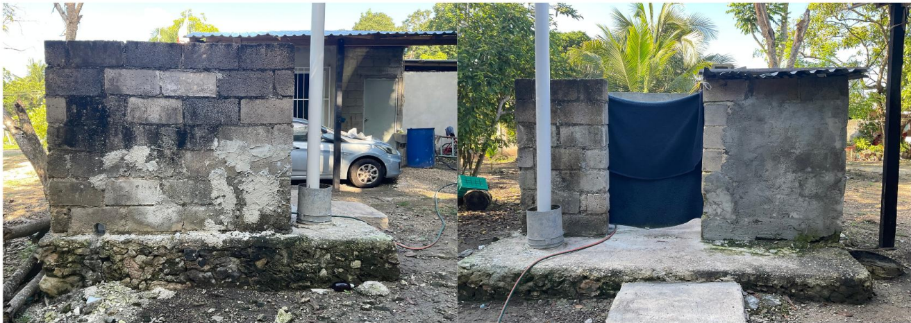
Imagen 23. Construcción de un baño en el exterior de la vivienda tipo P3
