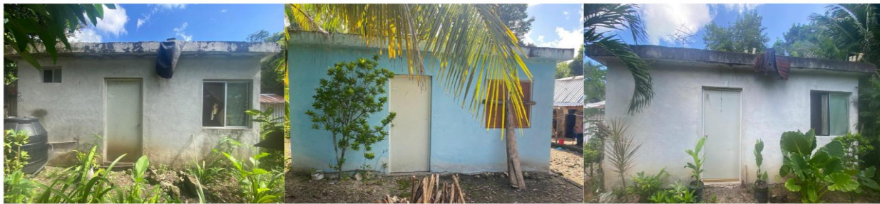
Imagen 8. Fotos de viviendas del Programa de Reconstrucción de Viviendas Dañadas por el Huracán Dean: Tipo P1
