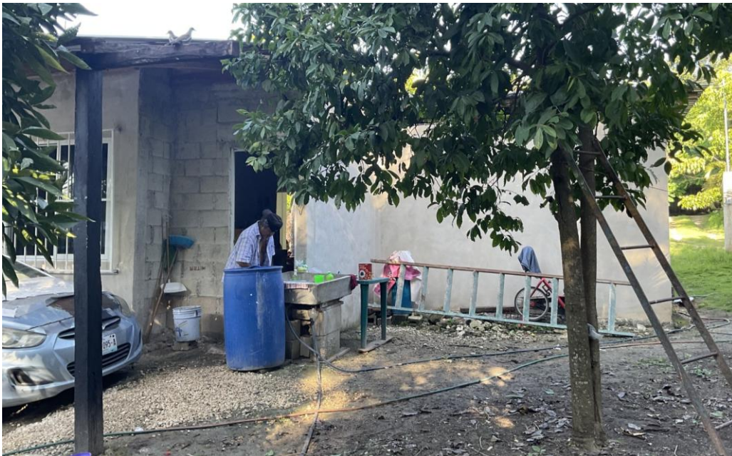
Imagen 25. Adaptación en el exterior de una vivienda tipo P3 en Palmar
