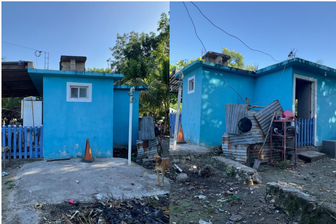
Imagen 11. Modificación realizada a una vivienda tipo P1 en Palmar
