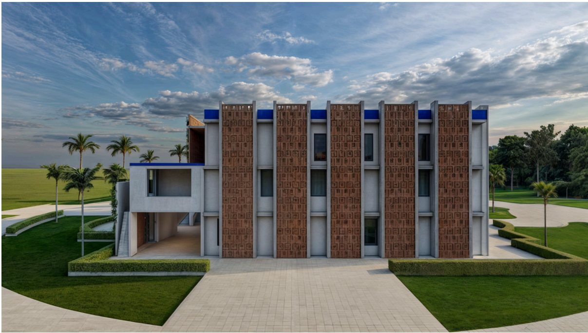
Figura 4.21. Lateral derecho (sur) del edificio administrativo.
