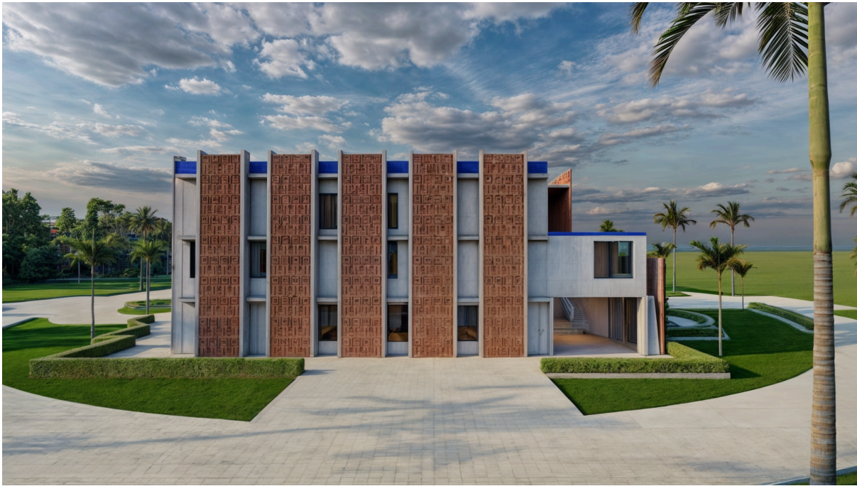
Figura 4.22. Lateral izquierdo (norte) del edificio administrativo.
