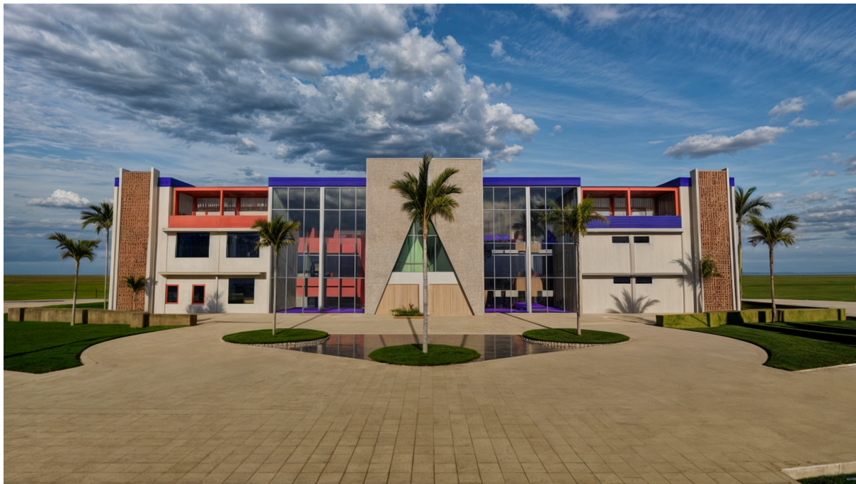
Figura 4.20. Fachada posterior (este) del edificio administrativo.
