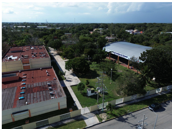
Figura 3.41. Acometida de red de energía eléctrica. Fuente: capturado por el autor.
