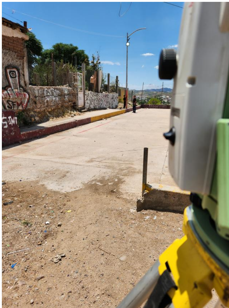
Ilustración 33. Levantamiento topográfico con estación total – toma de datos
