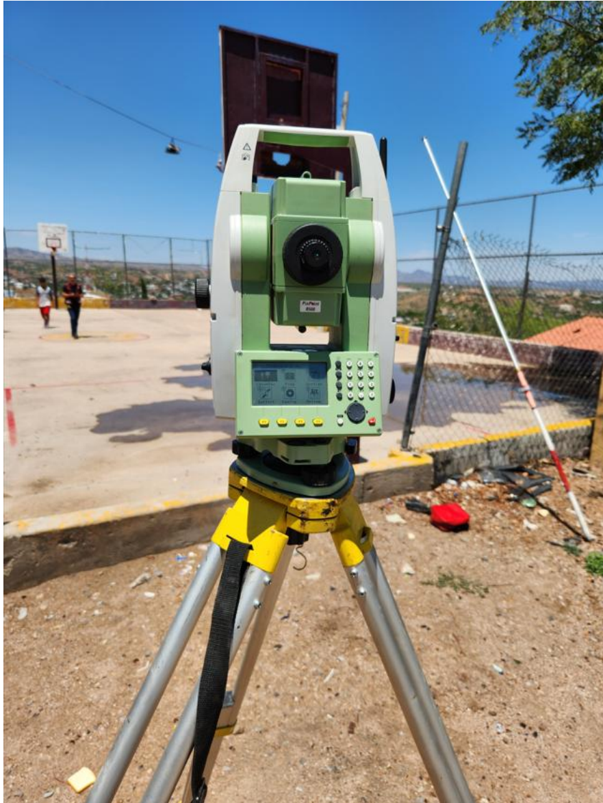
Ilustración 34. Levantamiento topográfico – equipo Leica TS06, toma de datos
