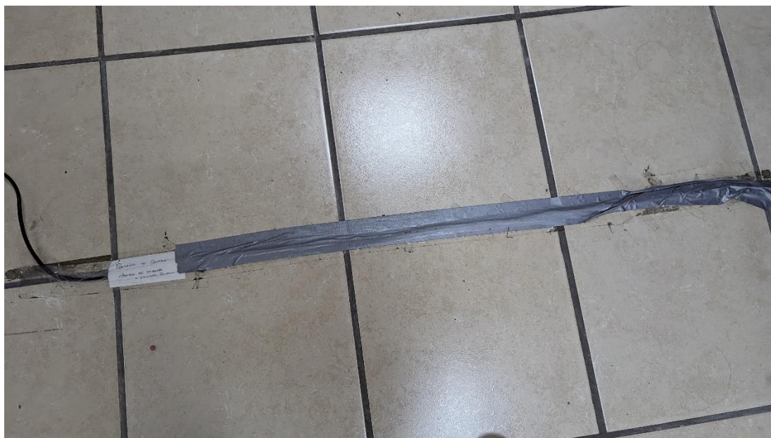
Figura 41. Sistema de Control Número 3. Evidencia 2. Cruce del cable ethernet por el pacillo. [Fuente: Elaboración propia].
