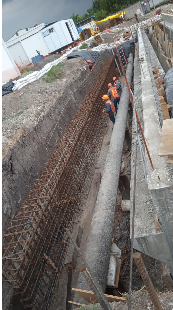
Figura 10- Levantamiento de muros de acero divisorios
