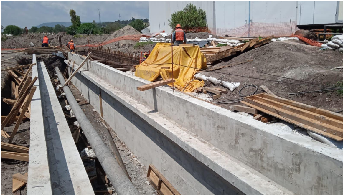
Figura 20- Muros de trinchera desencofrados
