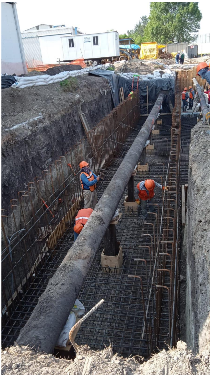
Figura 7- Amarre de acero de losa de cimentación
