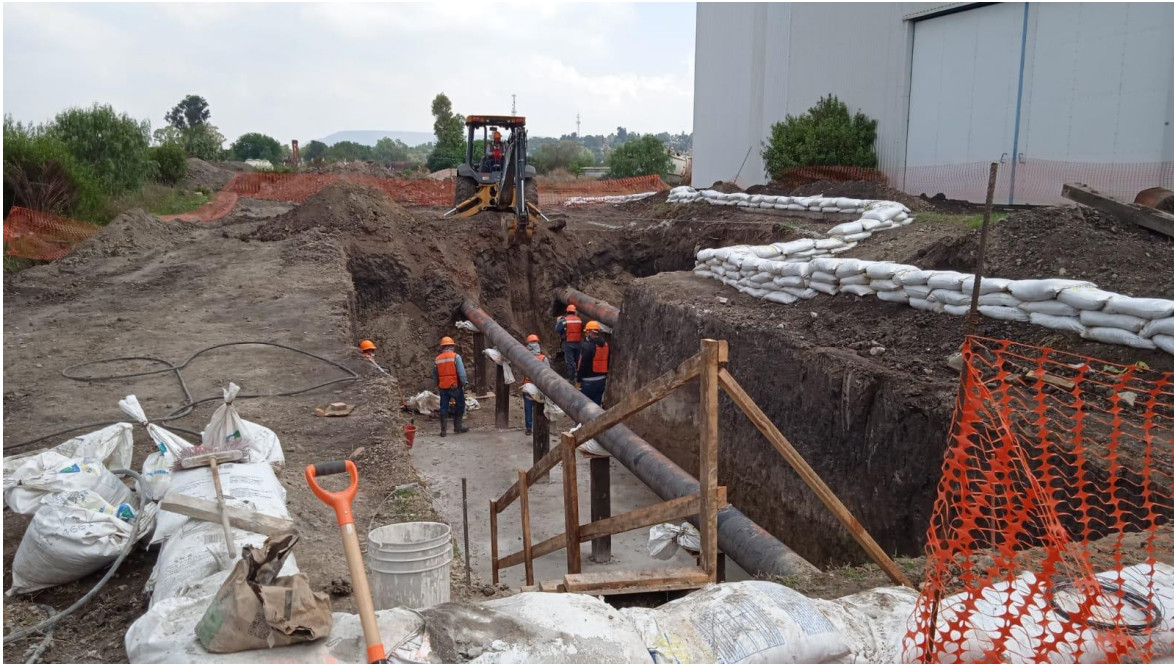
Figura 3- Personal de obra descubriendo ductos de Pemex
