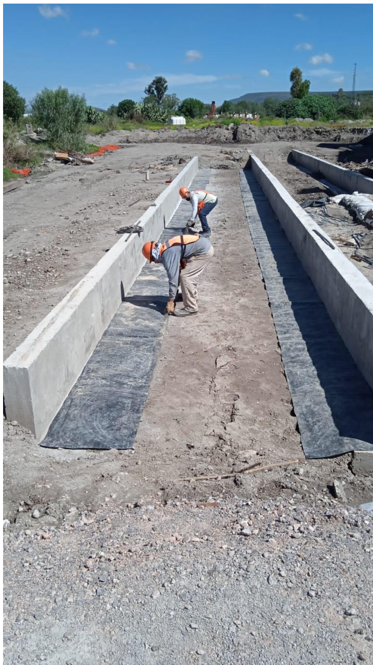
Figura 30- Colocación de suelas de neopreno
