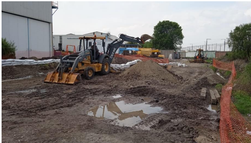
Figura 2- Excavación de trincheras
