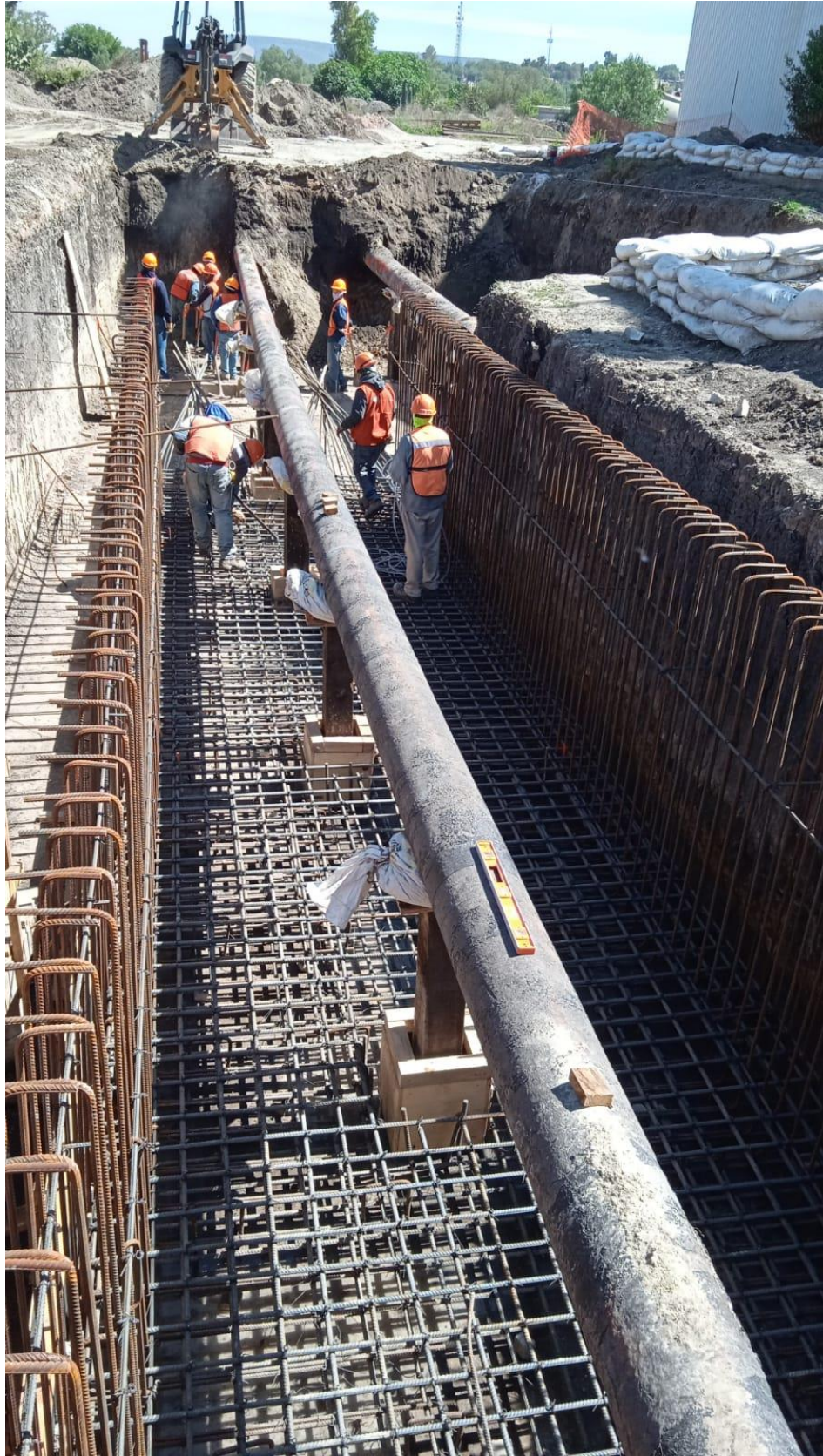
Figura 8- Acero de losa de cimentación
