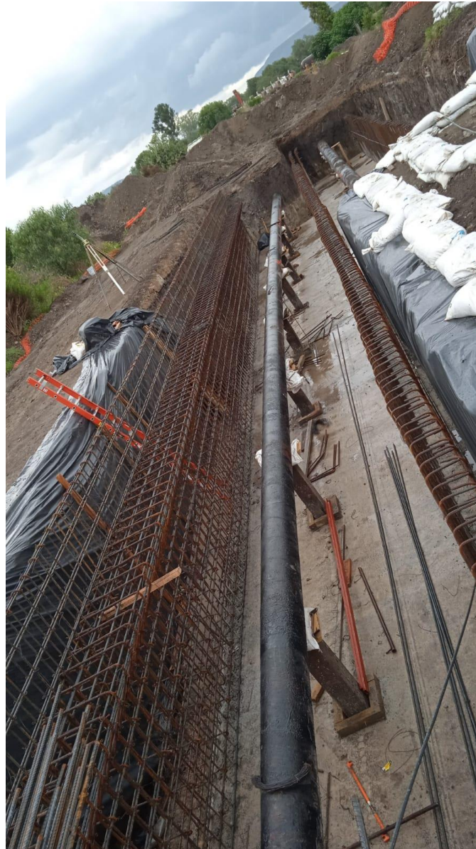
Figura 13- Muro lateral terminado hasta el acero
