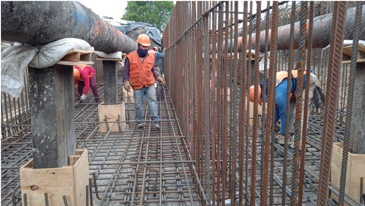
Figura 6- Amarre de acero de losa de cimentación
