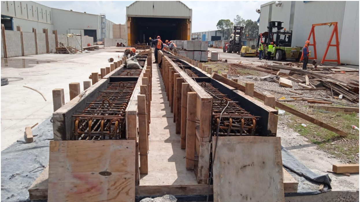
Figura 28- Encofrado de trabe losas
