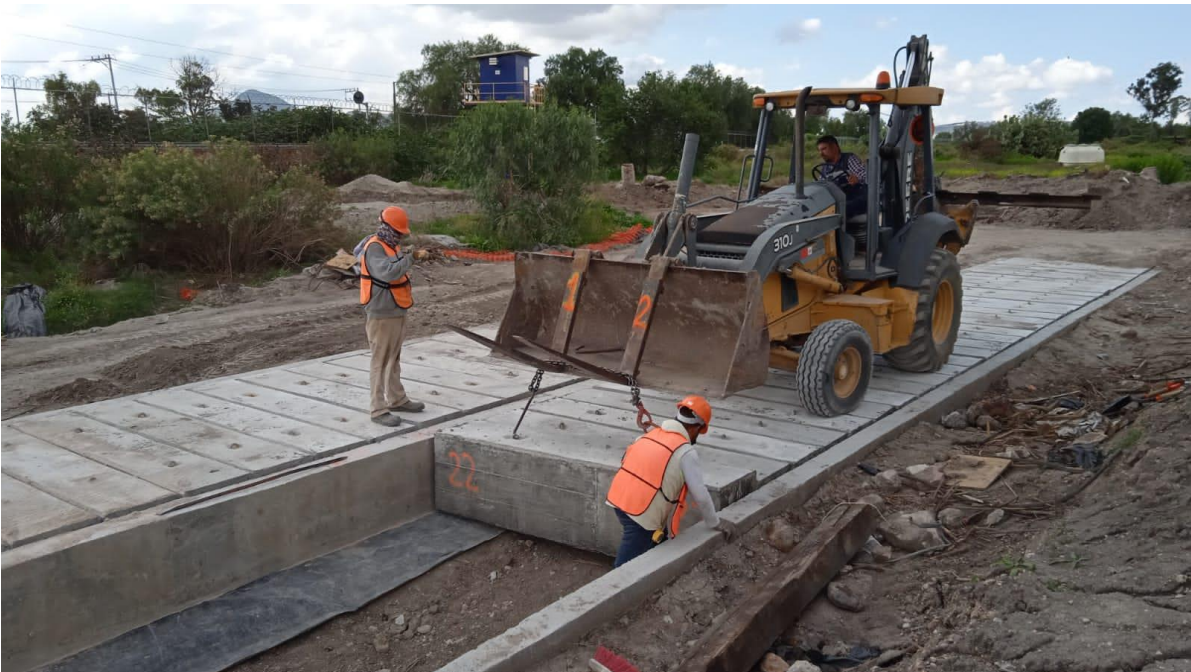
Figura 32- Colocación de trabe losas en trinchera
