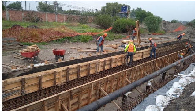
Figura 14- Encofrado de muro lateral, usando amarre de mariposa
