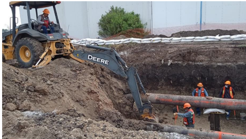
Figura 1- Excavación de trincheras
