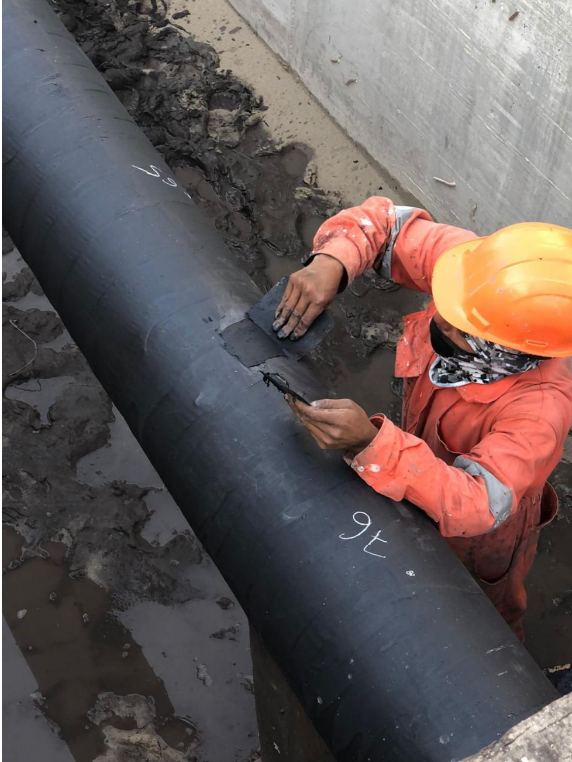
Figura 23- Aplicación de recubrimiento de ducto
