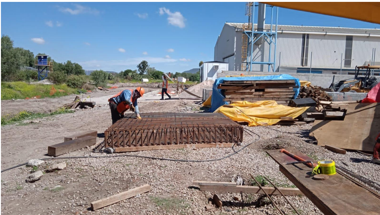
Figura 26- Armado de trabe losas
