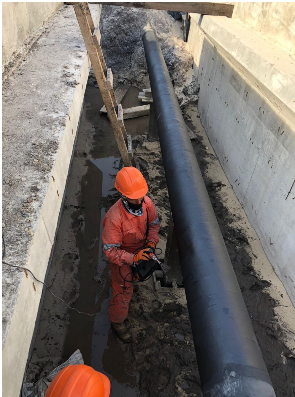
Figura 21- Pruebas a ductos por Pemex
