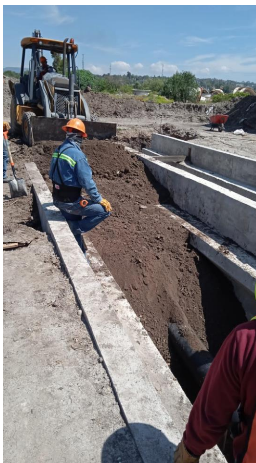
Figura 24- Relleno de trincheras
