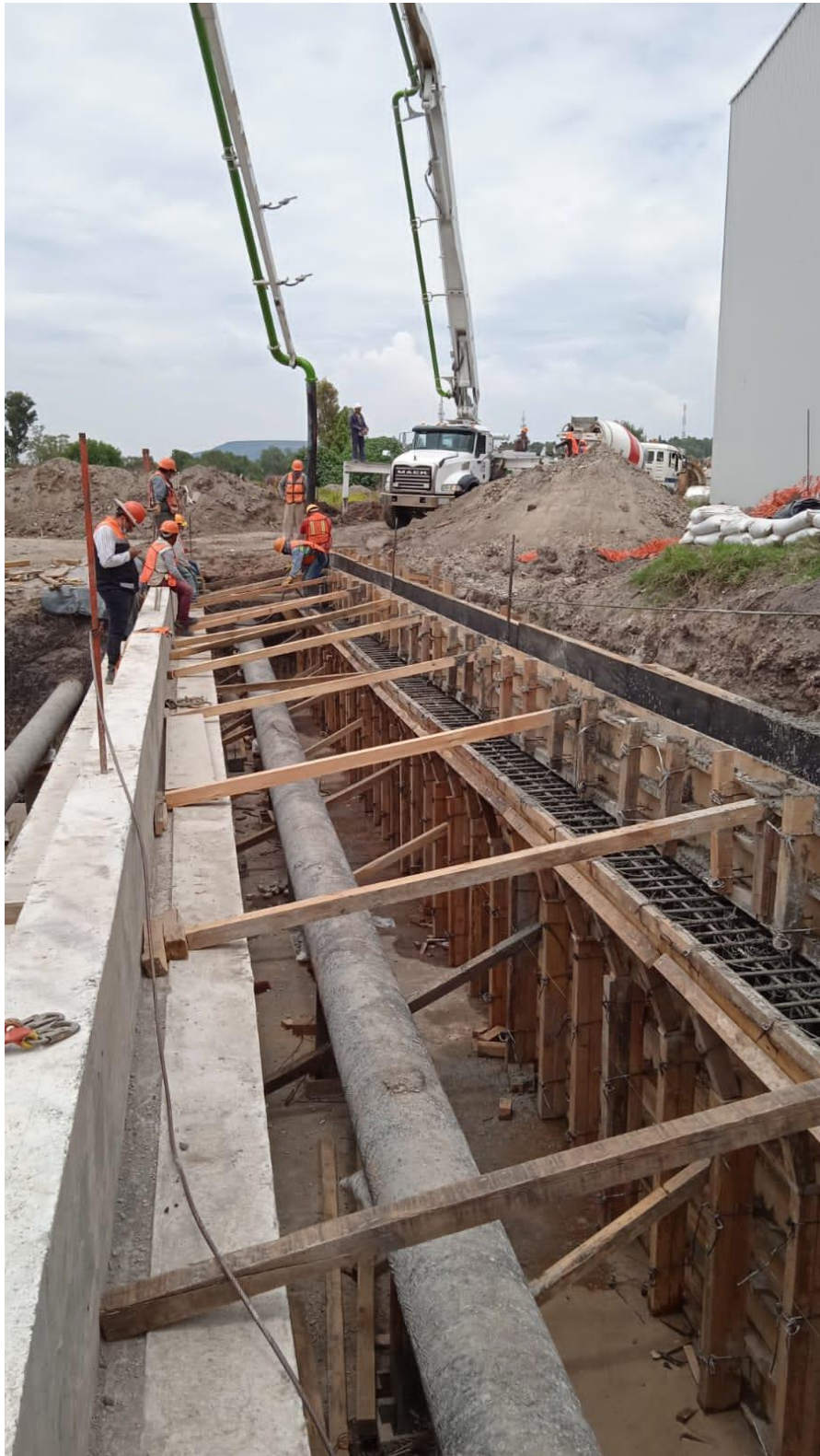
Figura 17- Colado de muro central, con bomba
