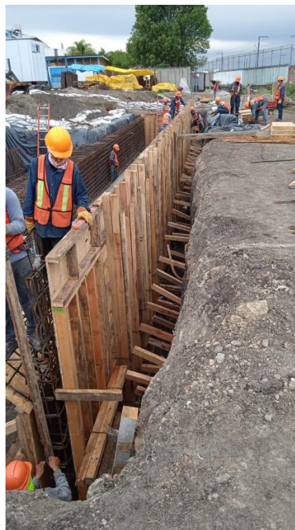
Figura 15- Encofrado de muro lateral, apuntalado zona trasera
