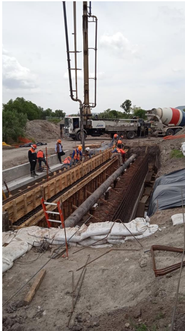
Figura 18- Descargue de concreto con bomba en muro central
