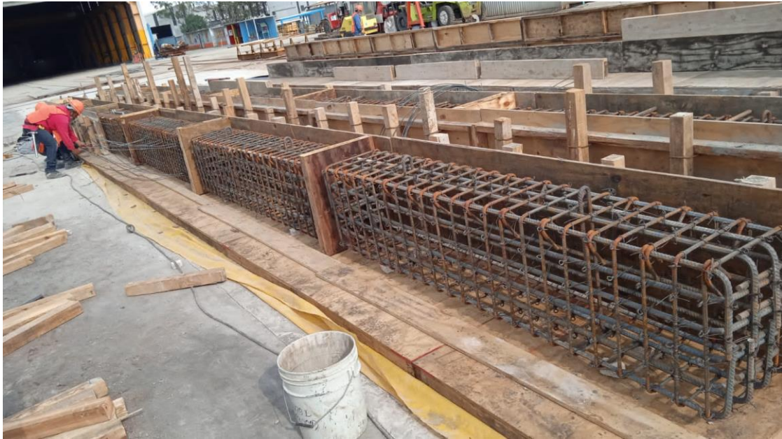
Figura 27- Encofrado de trabe losas
