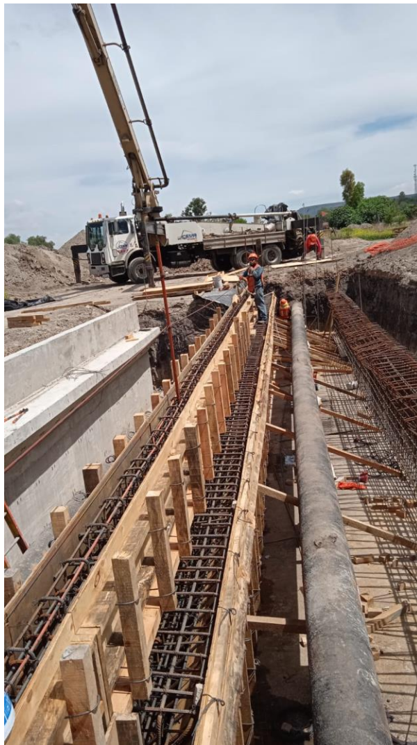
Figura 11- Acero encofrado de muro central
