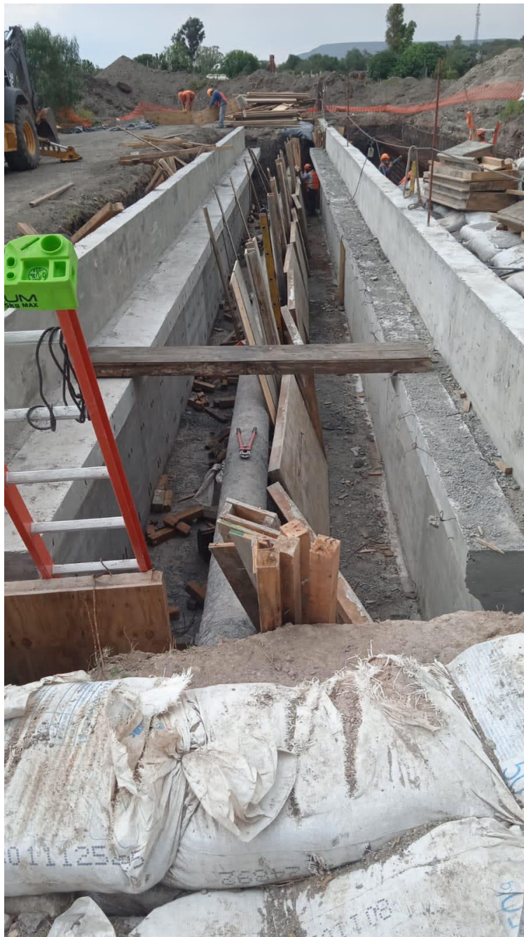
Figura 19- Desencofrado de muro central
