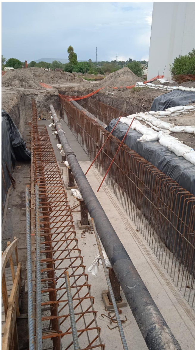
Figura 12- Armado de acero de ménsula
