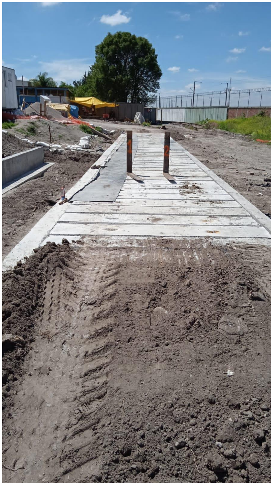
Figura 33- Trabe losas colocadas en trinchera, apoyo de uñas de carga
