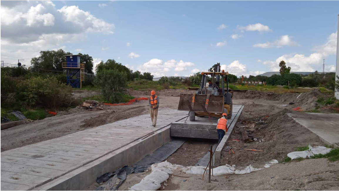
Figura 31- Colocación de trabe losas en trinchera
