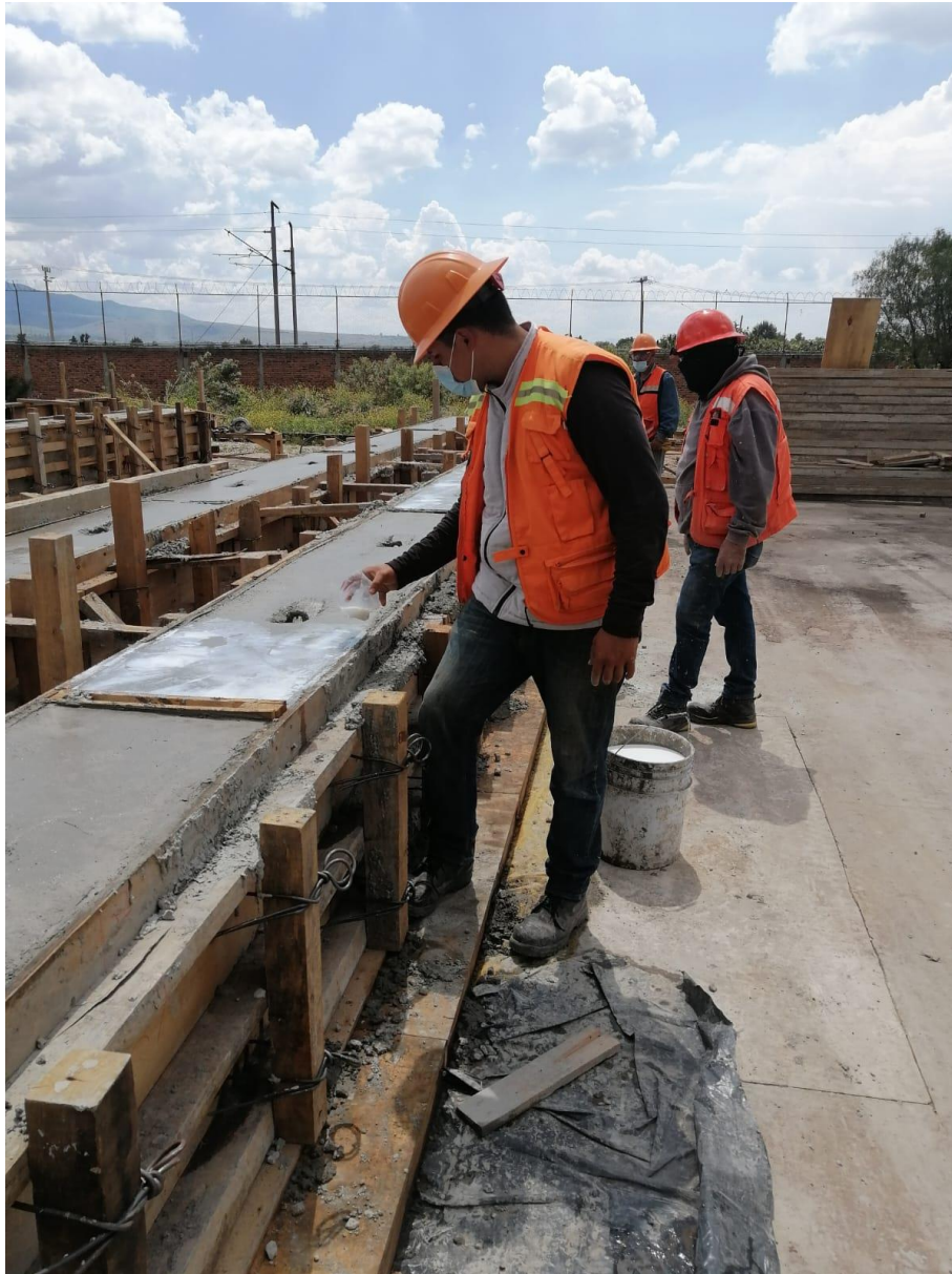
Figura 29- Curado de trabe losas
