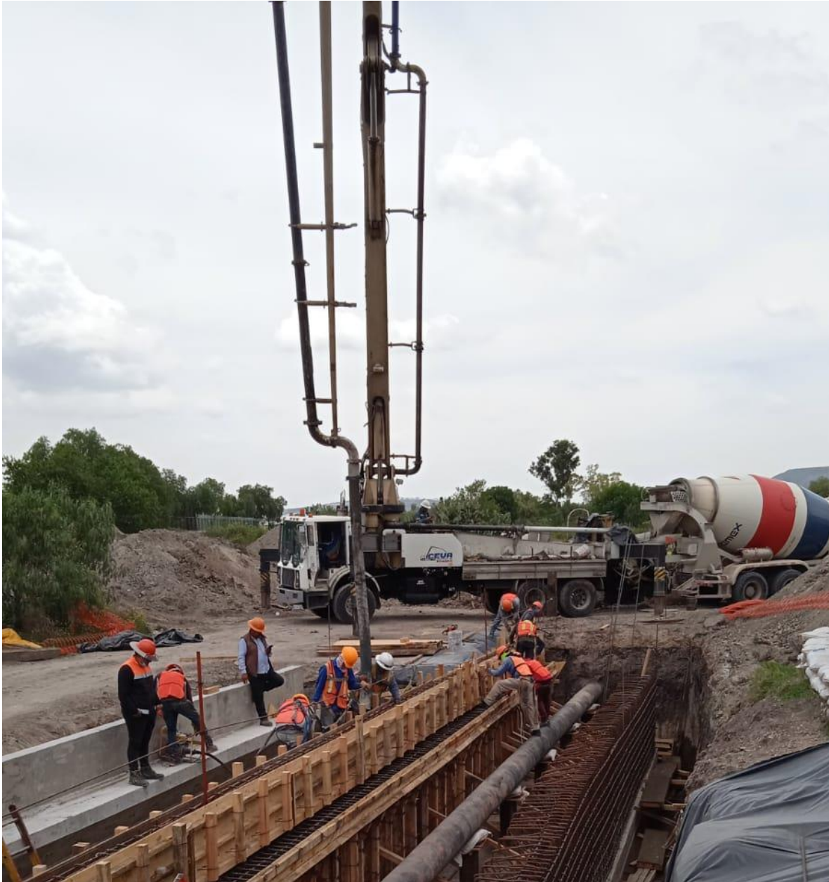
Figura 9- Colado de muro central con bomba
