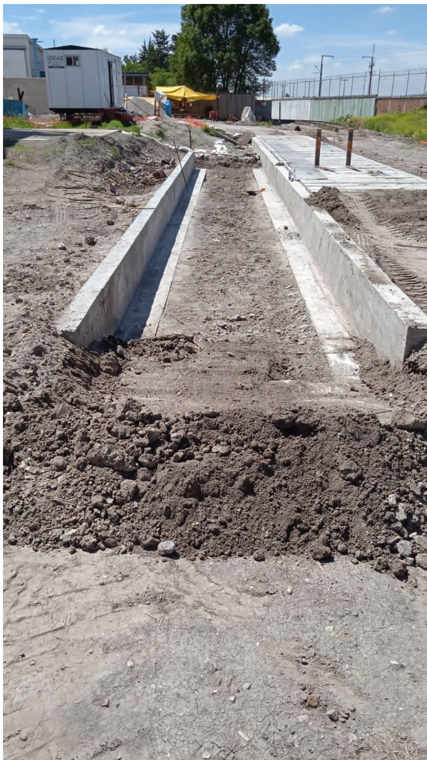
Figura 25- Compactación en trinchera de material
