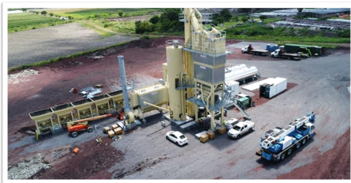
Figura 15 Equipo y componentes de planta discontinua (Autoría propia)
