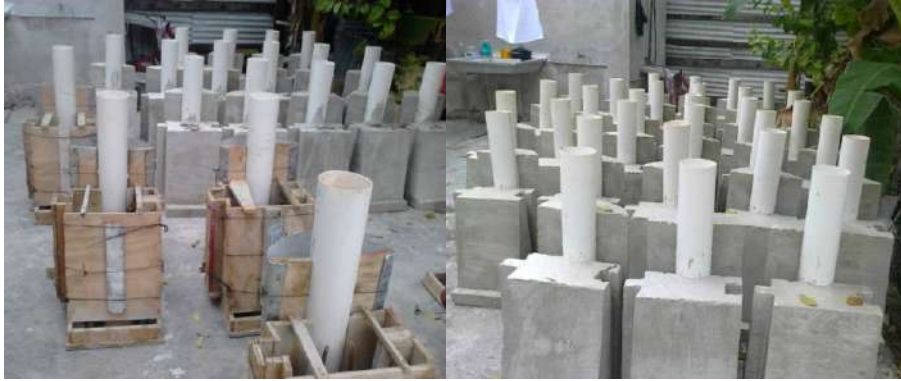
Fig. 5. Estructuras modulares, ensamblables para crear islotes artificiales.
