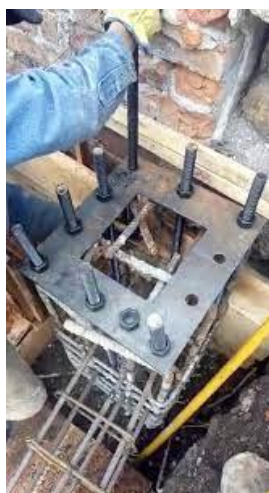
FIGURA 12 – EJEMPLO TIPO DE ANCLA DE CIMENTACIÓN
