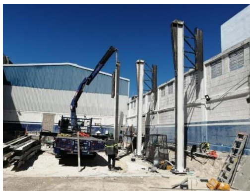
FIGURA 14 - EJEMPLO DE MONTAJE DE COLUMNAS DE ACERO CON GRUA
