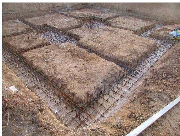
FIGURA 7 – EJEMPLO DE EXCAVACIÓN DE LA ZAPATA Y TRABE
