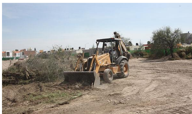
FIGURA 4 – EJEMPLO DE MAQUINARIA PESADA HACIENDO LIMPIEZA DEL TERRENO.
