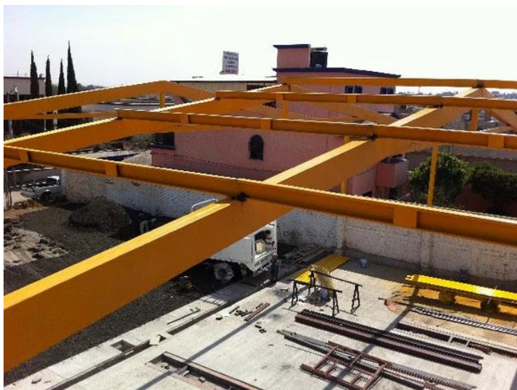
FIGURA 18 - EJEMPLO DEL LARGUERO DE LA ESTRUCTURA METALICA
