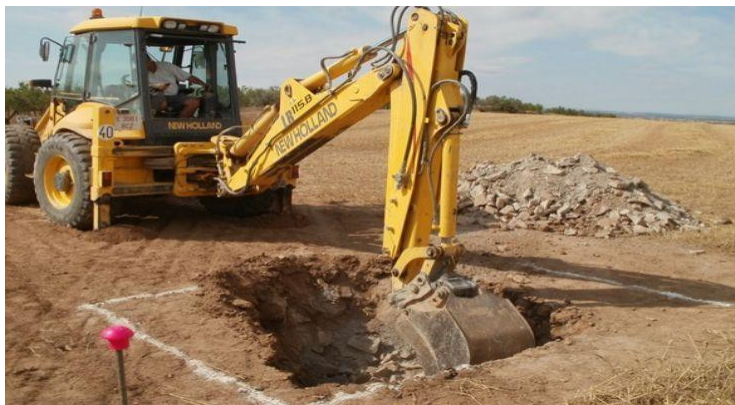
FIGURA 6 – EJEMPLO DE EXCAVACIÓN CON RETROEXCAVADORA DE LA CIMENTACIÓN
