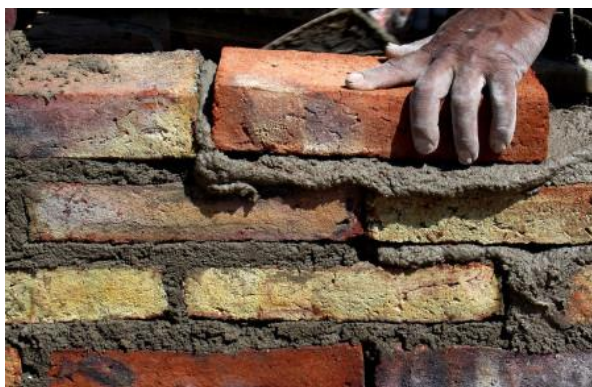
FIGURA 23 - EJEMPLO DE CONSTRUCCION DE MUROS DE TABIQUE ROJO RECOCIDO.
