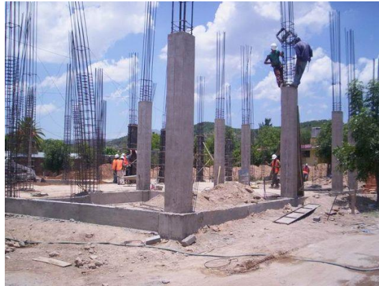
FIGURA 24 - EJEMPLO DE COLUMNAS DE LA ESTRUCTURA DE CONCRETO
