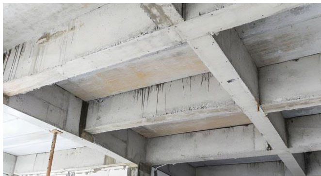
FIGURA 25 - EJEMPLO DE TRABES DE LA ESTRUCTURA DE CONCRETO.
