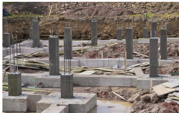
FIGURA 21 - EJEMPLO DE EXCAVACIÓN DE LA ESTRUCTURA DE CONCRETO
