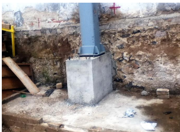
FIGURA 9 – EJEMPLO DE ZAPATAS AISLADAS CON ANCLAJE
