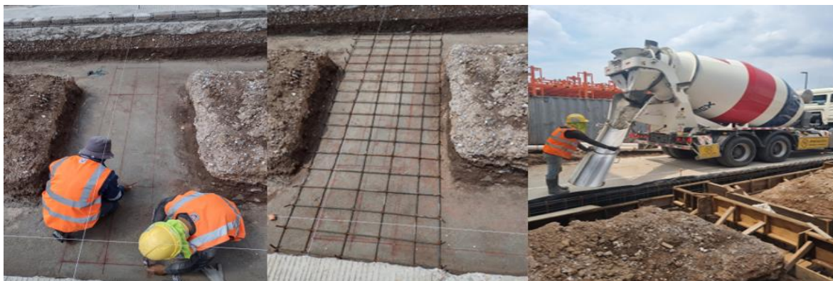
Ilustración 16.- Zapata corrida 1.20mx0.15mx3.50m
