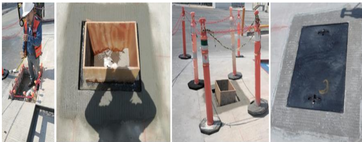
Ilustración 28.- Registro para cambio de dirección para drenaje pluvial.
