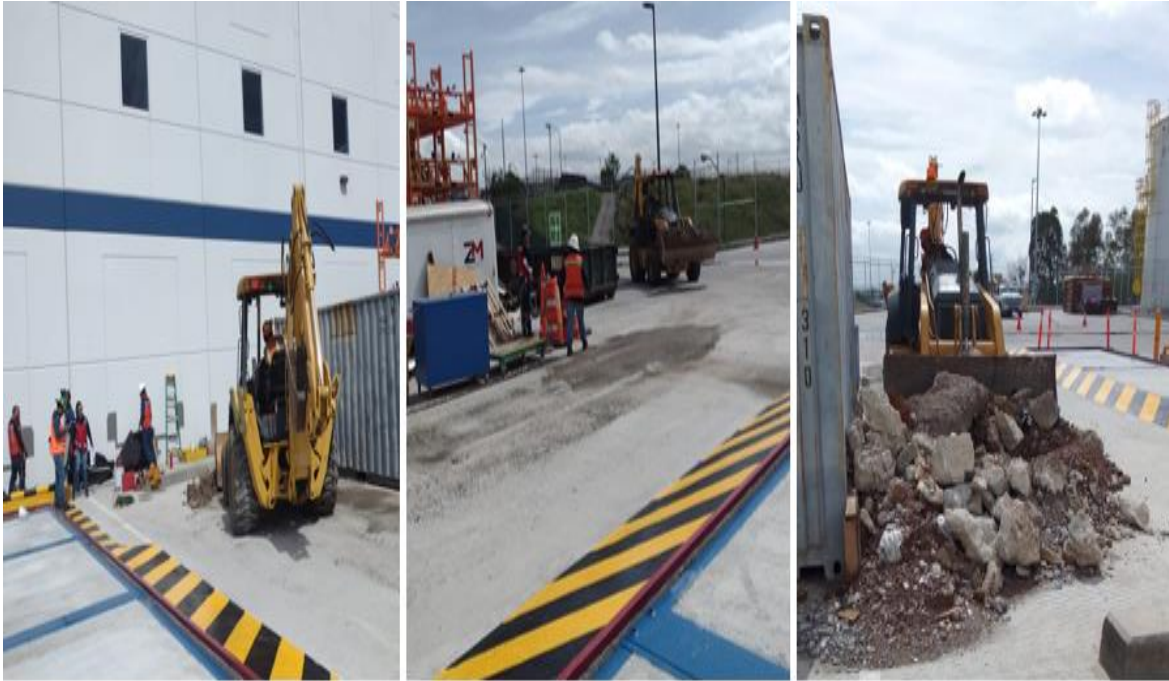
Ilustración 44.- Retiro de material producto de la excavación.
