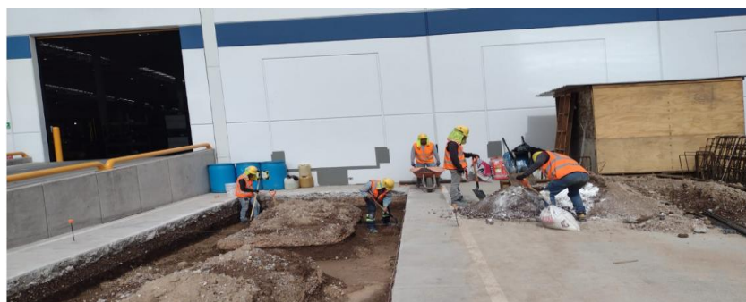
Ilustración 14.- Afine de talud
