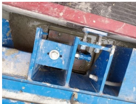
Ilustración 32.- Cimbra para anclas de celdas.
