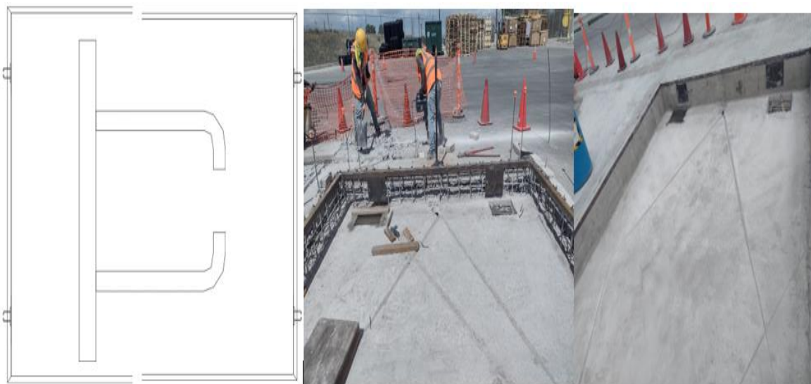
Ilustración 34.- Tope de placa de acero
