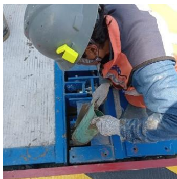
Ilustración 33.- colado de preparaciones para anclas de celdas.
