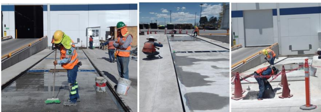
Ilustración 37.- Curado de elementos de concreto
