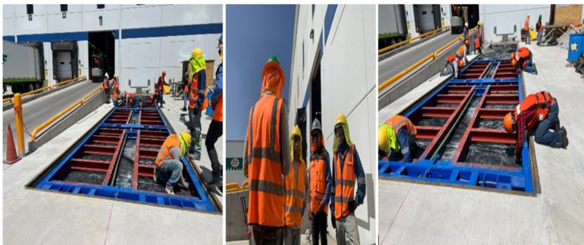
Ilustración 35.- Colocación de hule negro como cimbra
