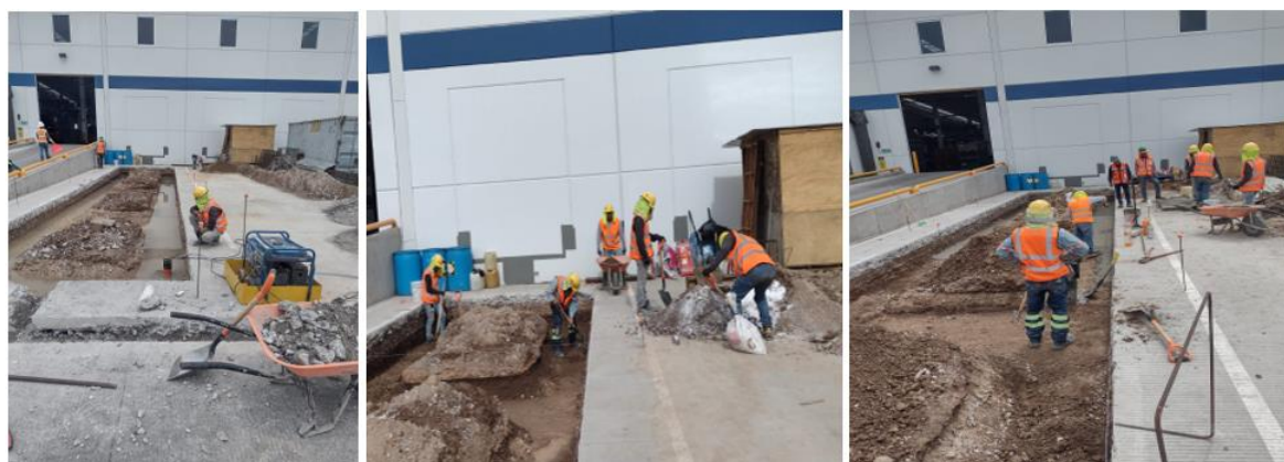
Ilustración 12.- Mejoramiento del terreno natural.
