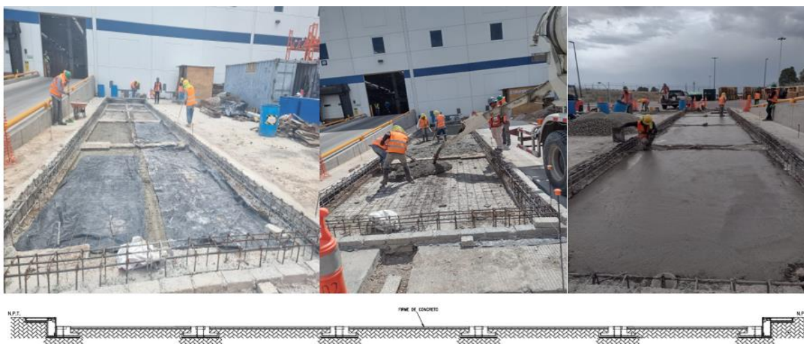
Ilustración 21.- Losa de cimentación.
