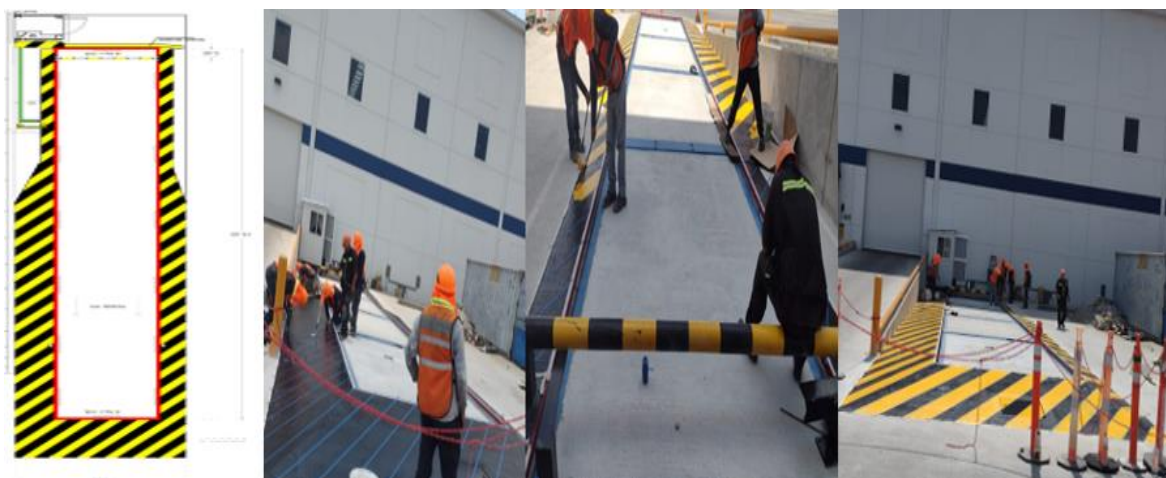
Ilustración 42.- Pintado de bandas de señalamiento.
