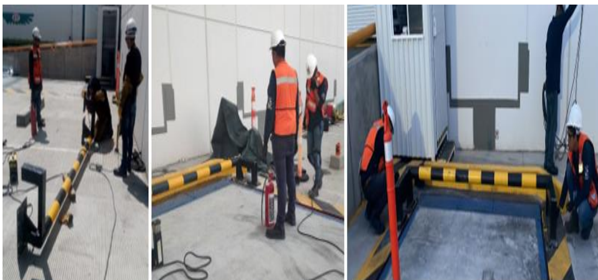
Ilustración 47.- Instalación de tope.
