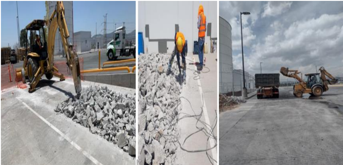
Ilustración 9.- Demolición de concreto por medios mecánicos.
