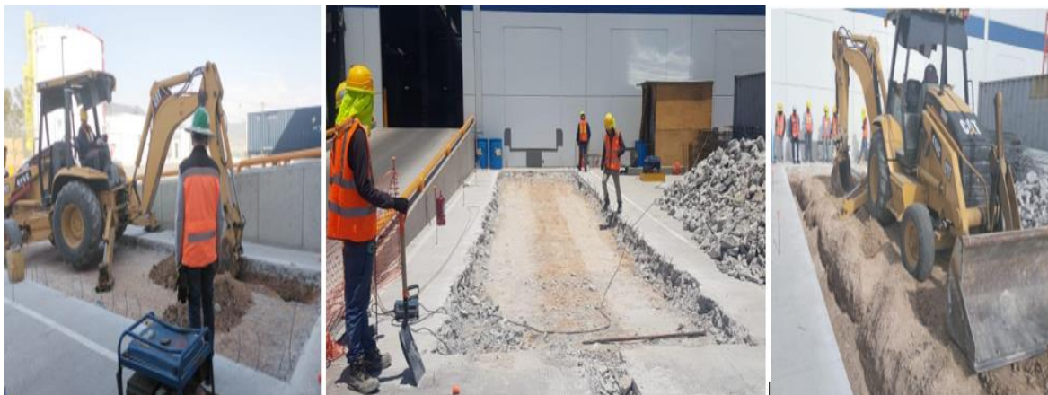
Ilustración 10.-Excavación a cielo abierto
