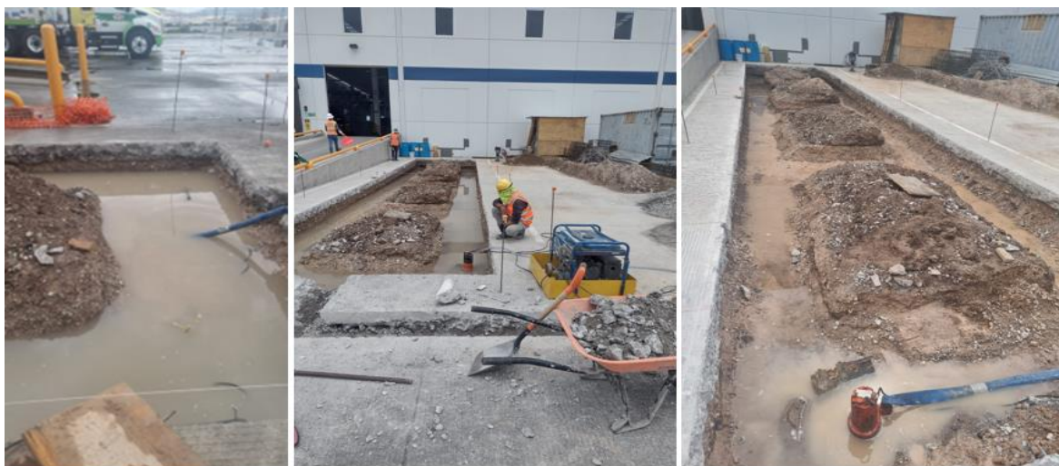
Ilustración 11.- Achique en trinchera para cimentación.
