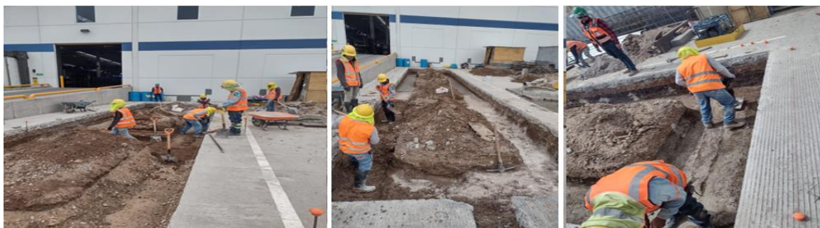
Ilustración 13.- Escarificación y compactación.
