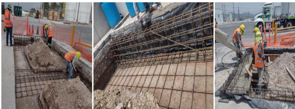
Ilustración 17.- Armado, cimbrado, y colado de zapata corrida de 0.75 m x 0.15 m y 3.50
