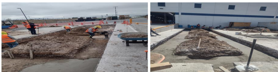
Ilustración 15.- Plantilla de 5 cm de espesor.
