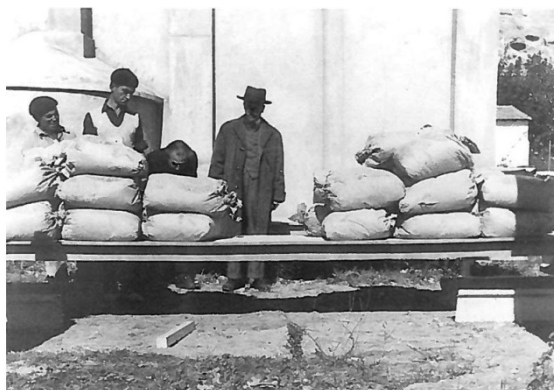
Figura 1. Prueba de carga en vigueta prefabricada pretensada. Controla el ensayo Francisco Fernández Conde (López et. al., 2015).
