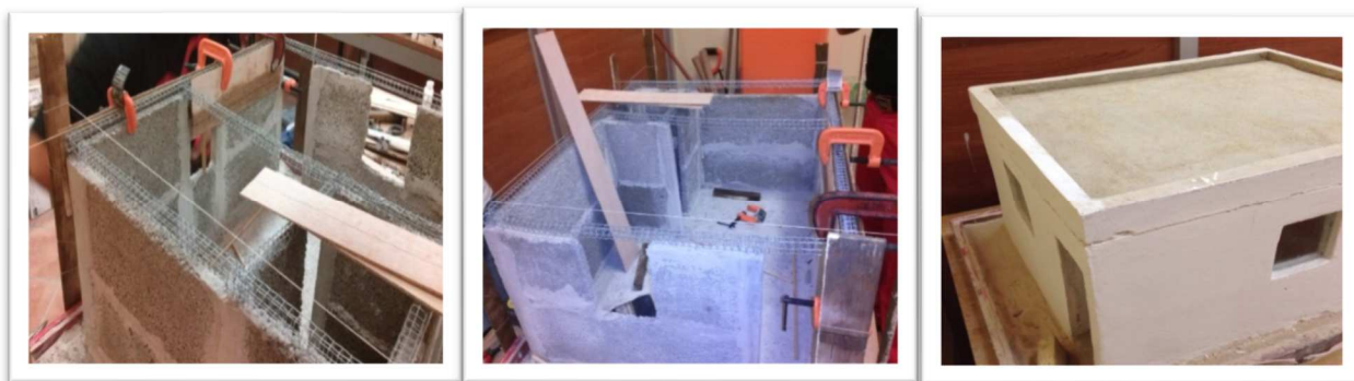
Figura 4. Cimbra y colado de trabes y acabados.
