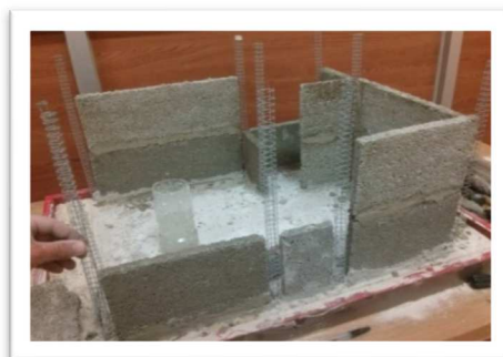
Figura 2 Desarrollo de muros de block
