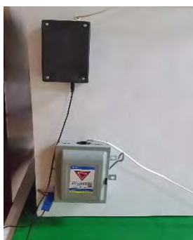
Figura 9. Instalación del dispositivo en el interruptor general.
