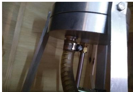
Figura 4. 24 Manguera y abrazadera conectadas a la cabina principal del reactor de plasma para la generación de vacío por parte de la bomba mecánica.
