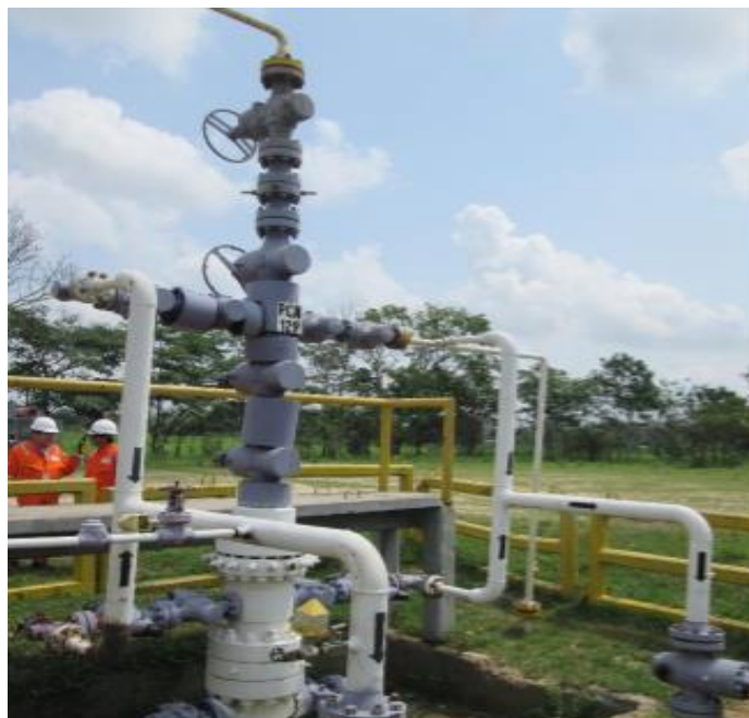
Imagen 3. 18 Localización "Pozo Cárdenas 129".
