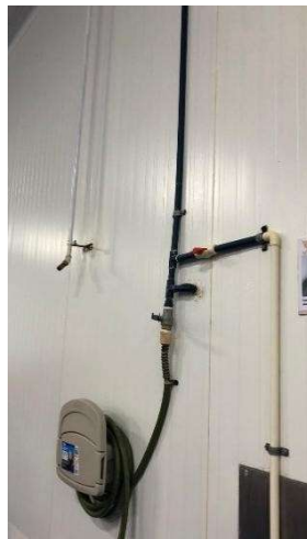
Figura 41 Tuberías sin señalización de fluidos
