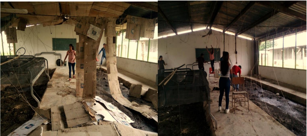
Figura 30. Desmantelado del techo de cartón y alambre.
