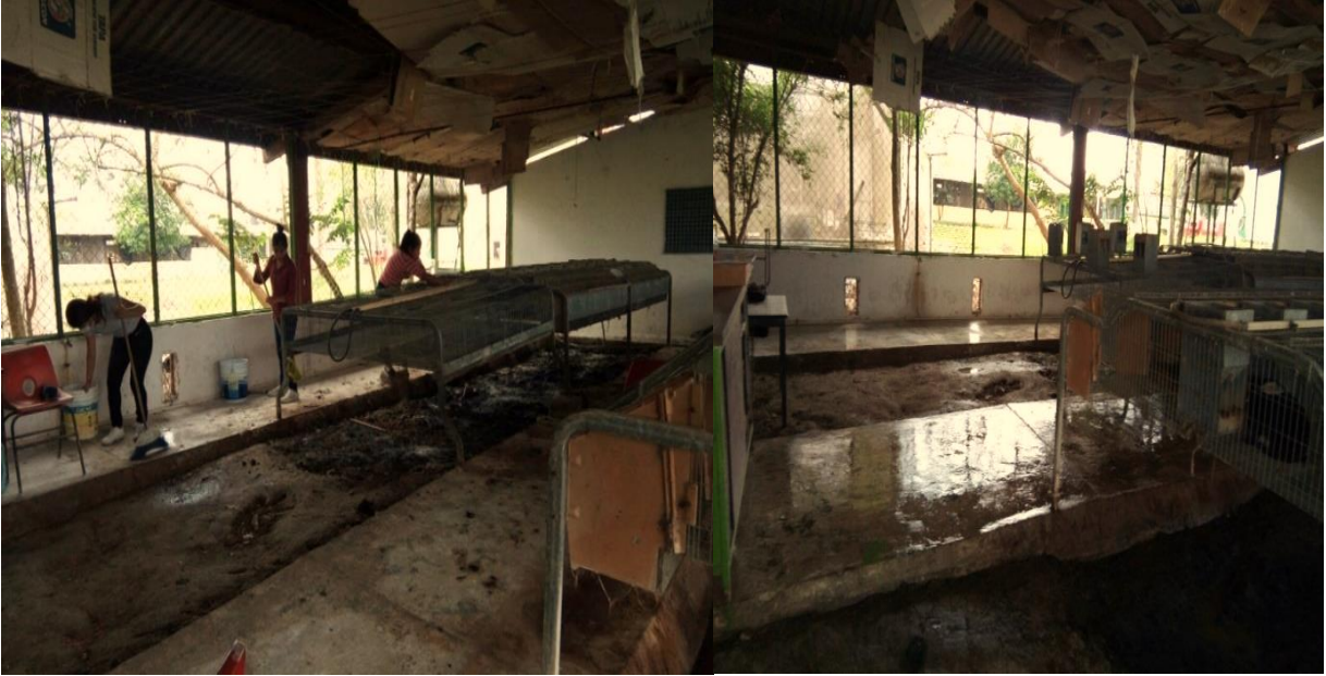
Figura 31. Lavado del piso y encalado calhida y sal, posteriormente se deajo reposar 12 horas.
