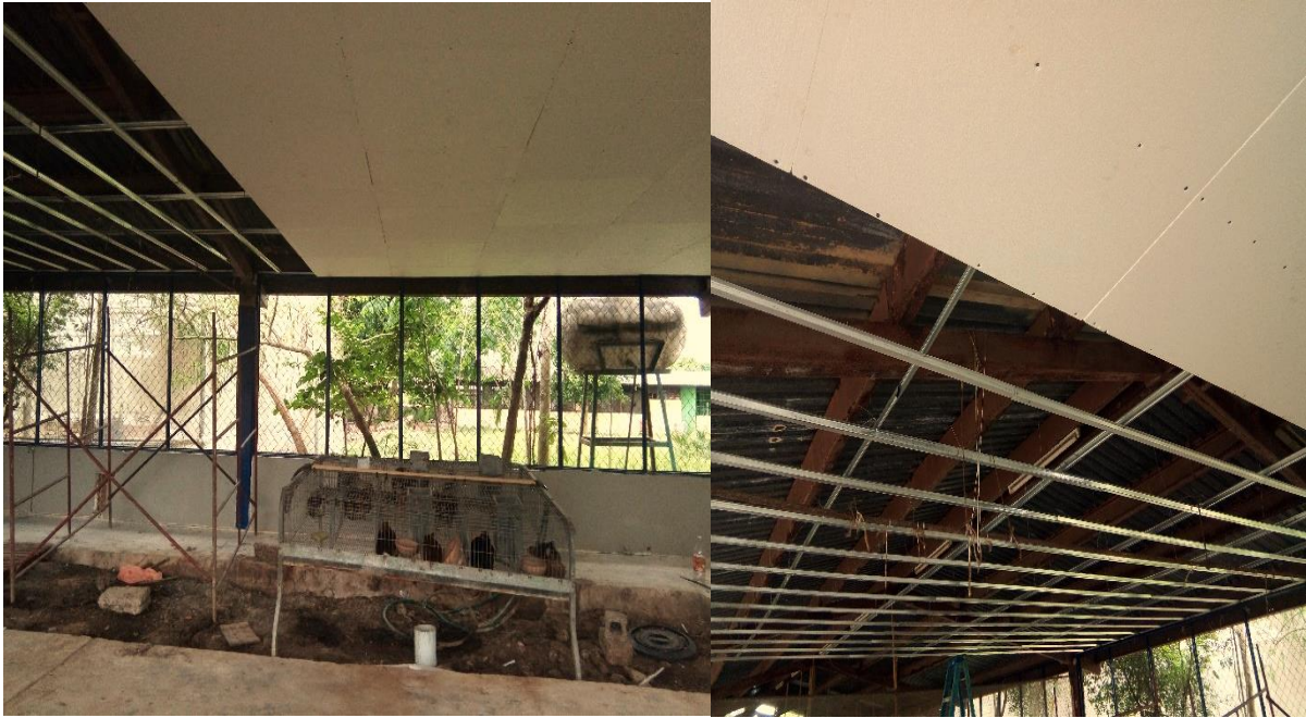
Figura 24. Instalación del techo de plafón y estructura metálica.
