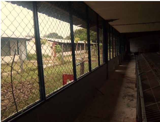
Figura 25. Aplicación de pintura de aceite en la malla ciclónica y los muros con pintura de agua.
