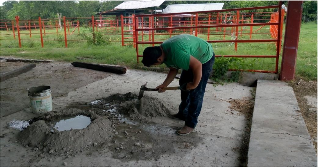
Img. 9 Preparación de concreto para la fijación de los postes.
