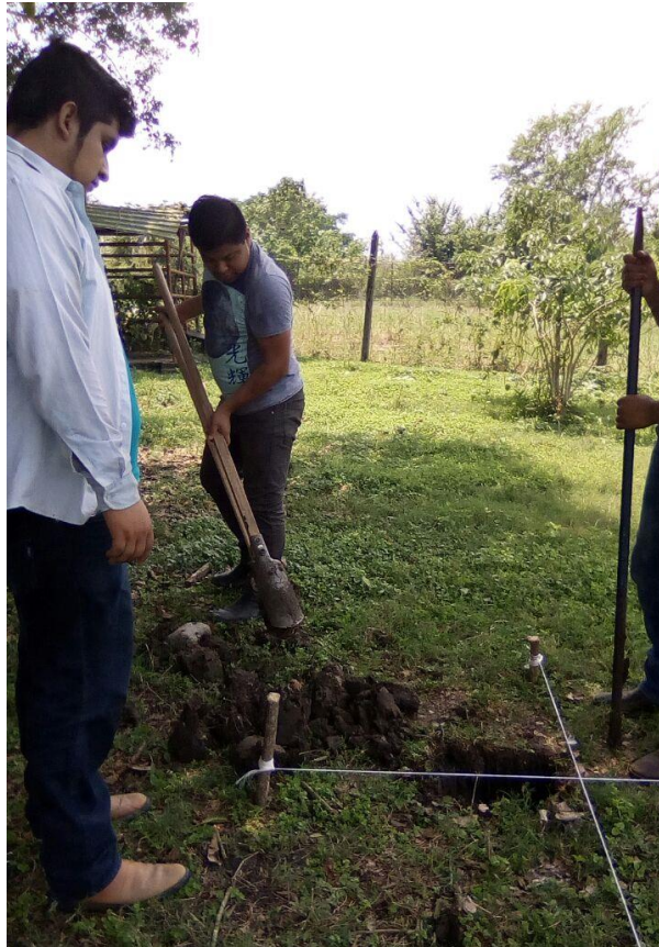
Img. 7 Realización de los orificios para la colocación de los postes.
