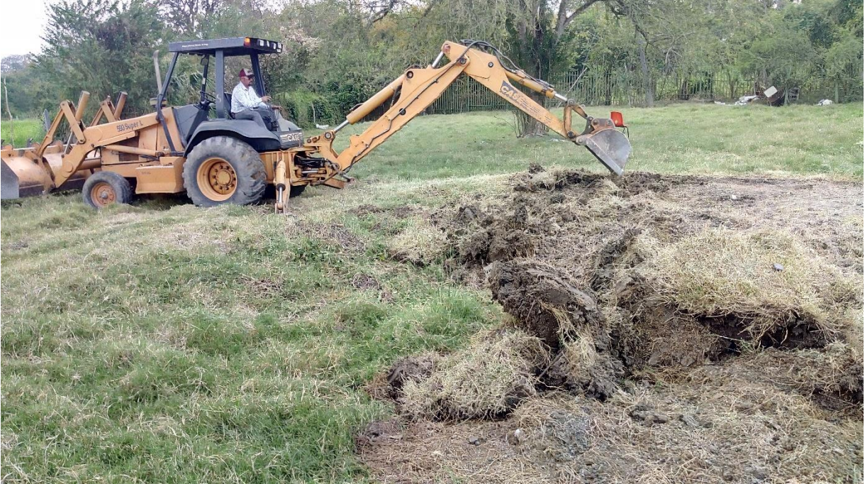
Img. 5 Acondicionamiento del terreno (Retroexcavadora).
