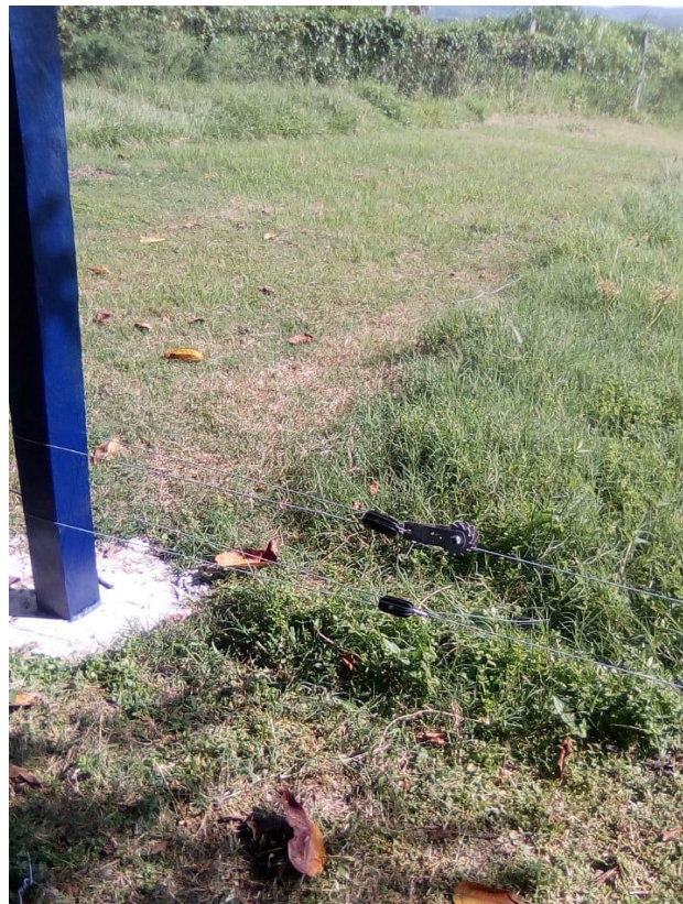
Img. 12 Colocación del Alambre Triple Galvanizado calibre 12.5 para el Cerco Eléctrico.
