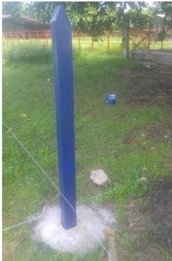
Img. 10 Postes fijados.
