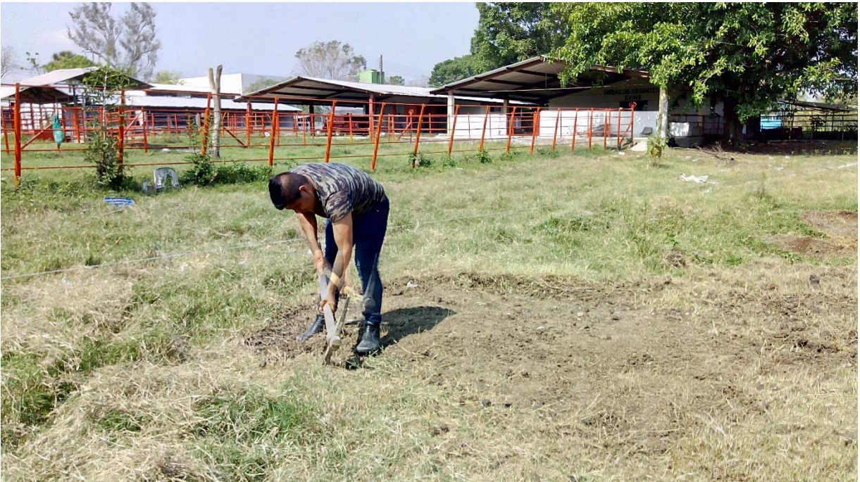
Img. 4 Acondicionamiento del terreno (Manual).
