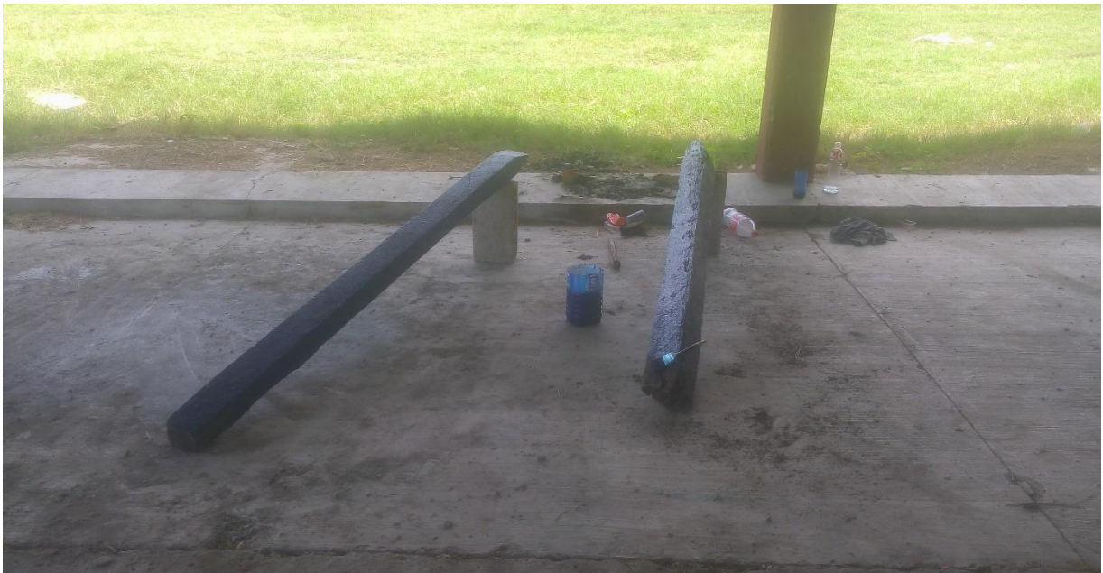
Img. 8 Colocación de pintura a los postes.
