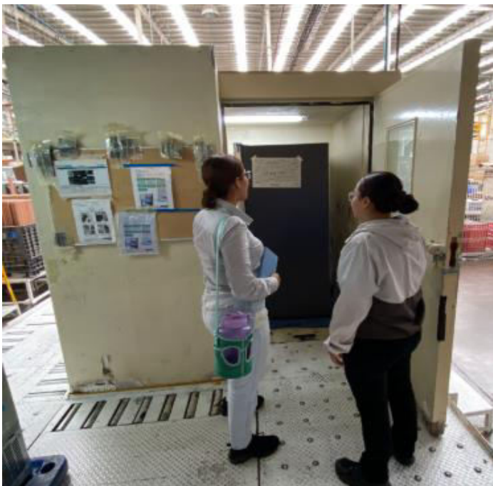
Ilustración 34. Alfi mostrando caseta L1 en mal estado.
