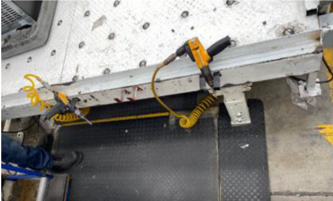
Ilustración 28. Resultado final de bases de pistolas neumáticas instaladas.
