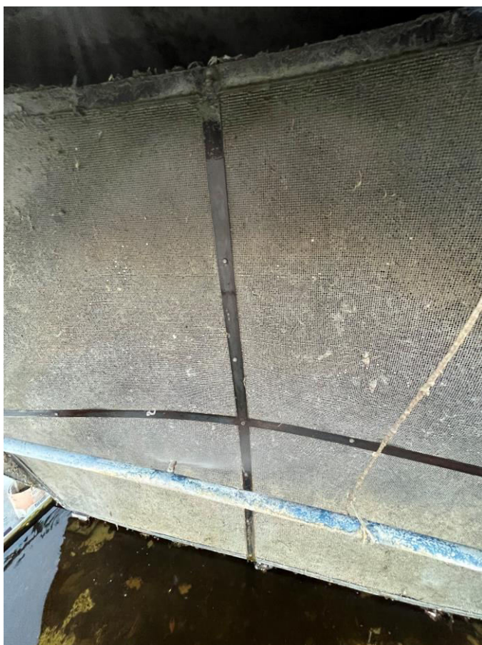
Figura 28 Sistema viejo de humectación de fibras de ductos
