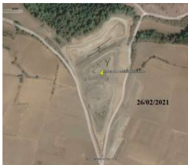
Figura 3.2 RESA ubicado en Tenango del Valle.
