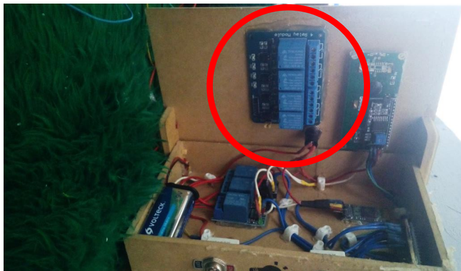
Figura 14 Conexión del módulo de relevadores.
