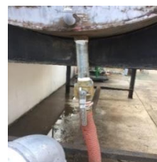
B.8 Válvula de salida del efluente tratado
