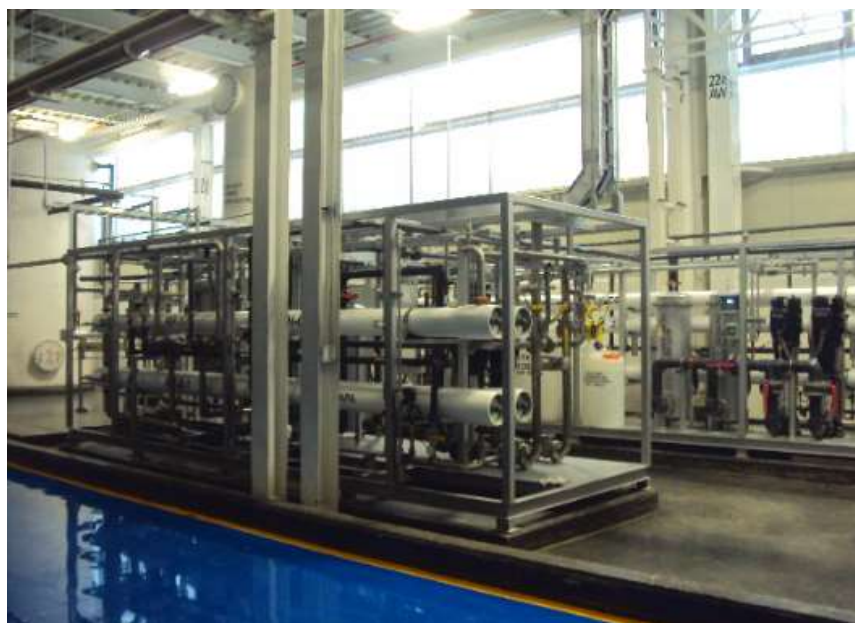
Figura 4.12 Módulos de ósmosis inversa.
