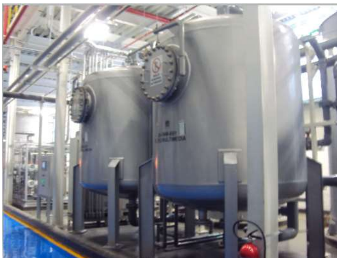
Figura 4.11 Sistema de filtro granular y retrolavado.
