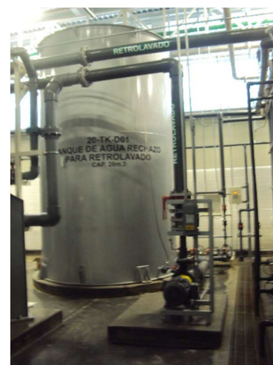
Figura 4.11 Sistema de filtro granular y retrolavado.
