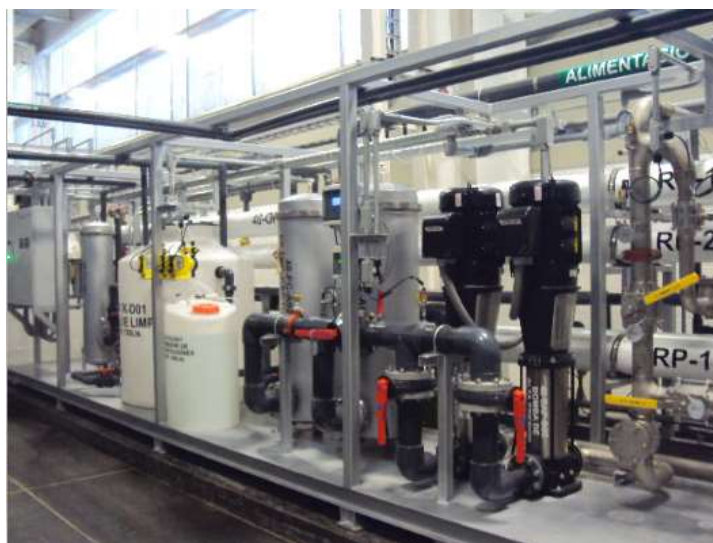
Figura 4.12 Módulos de ósmosis inversa.
